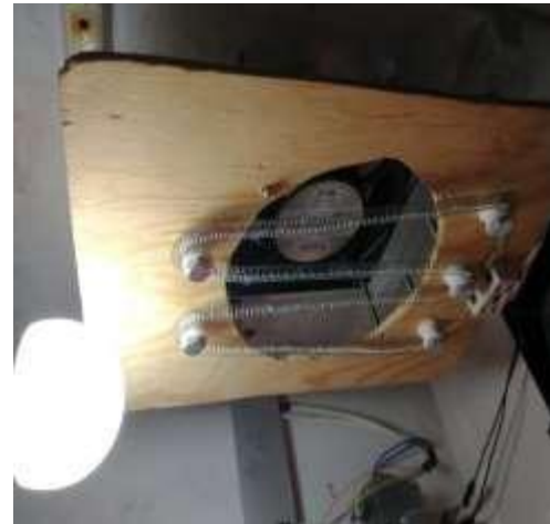
a) Ventilador y foco. Fuente: Elaboración propia.
