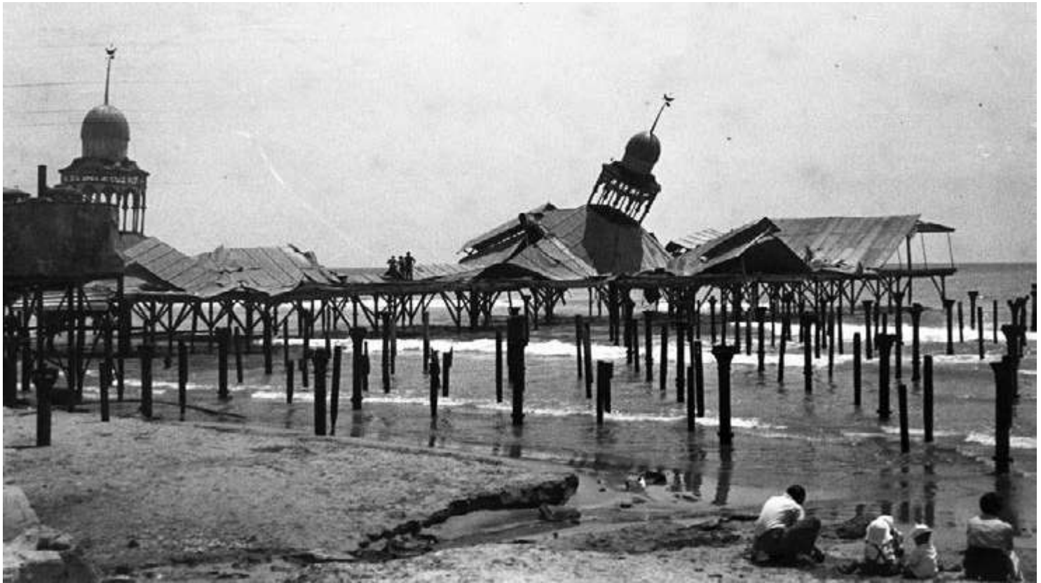
Foto 14- Estat del balneari Alhambra després dels bombardejos de la Guerra Civil. Sánchez. AMA
