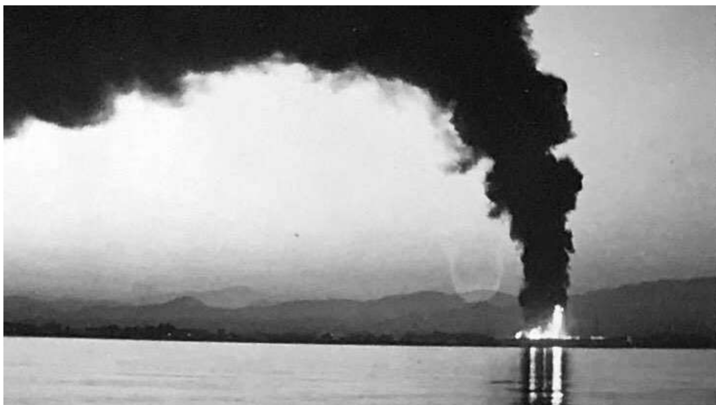
Foto 01- Bombardeig de les instal·lacions de Campsa. Càtedra Pedro Ibarra
