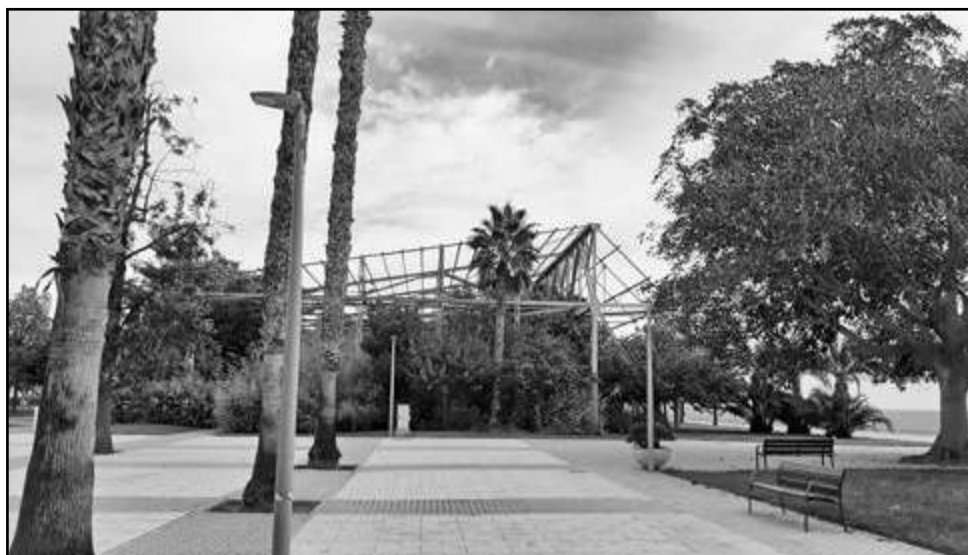
Foto 17- Estructura metàl·lica de l'hangar on s'observa la doble coberta asimètrica a dues aigües. Josep Antoni Pujol
