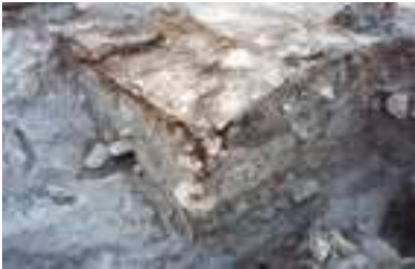
Departamento XX. Relleno inicial bajo el primer pavimento
