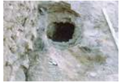
Departamento XXI. Silo
