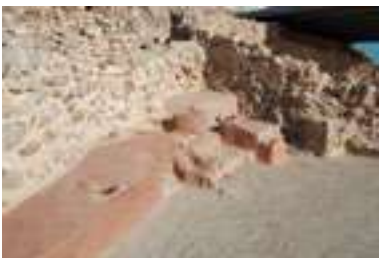
Departamento XXVII. Fase III tras los trabajos de restauración
