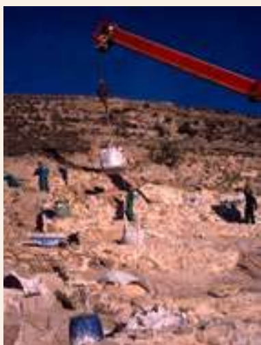
Tareas de consolidación y restauración del área excavada por Soler
