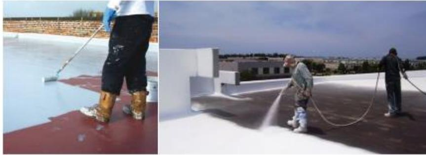
**Figure 2.15 :** Exemple des matériaux utilisés pour les toits froids ; de gauche à droite ; membranes monocouches ; bitume modifié et des peintures. (Source : (Costanzo, 2016)
