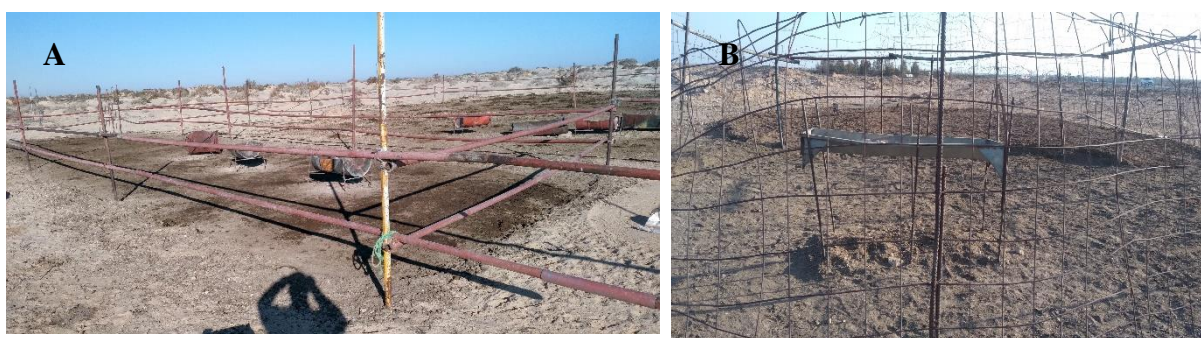
Photo 20. Logement enclos ( Houche ) en fer pour les dromadaires
