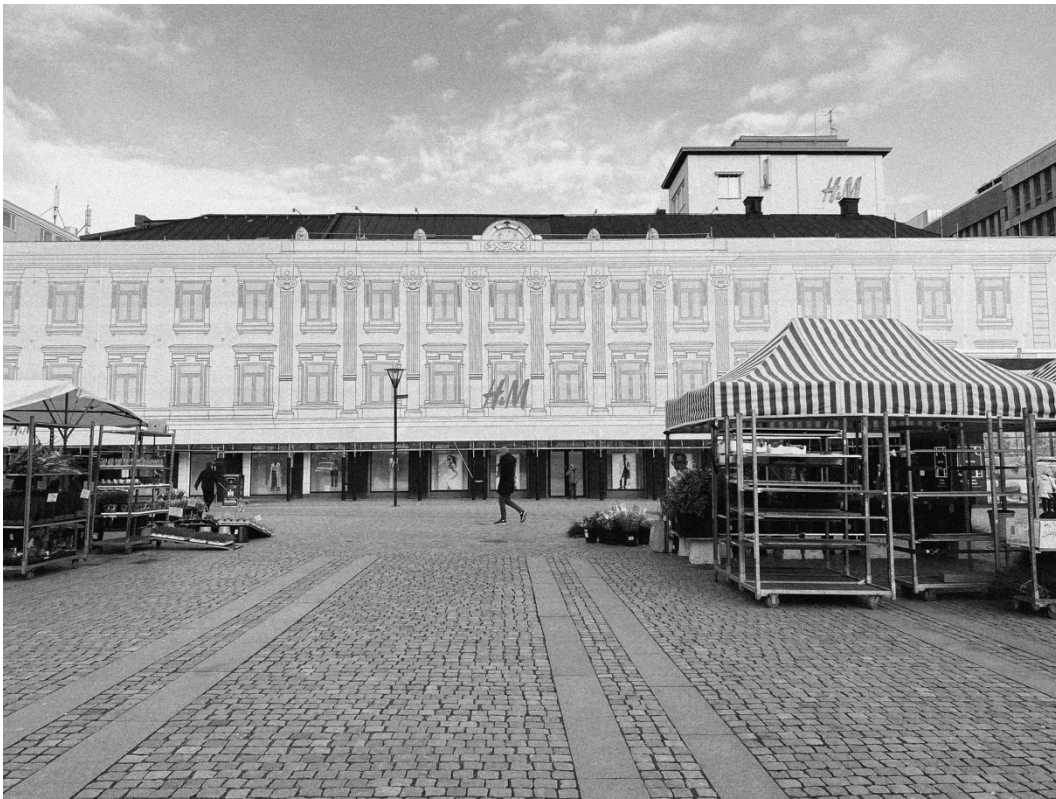
Figur 3. Ponnert, L. (2024) Ombyggnation av husfasad på Gustav Adolfs torg, Malmö
