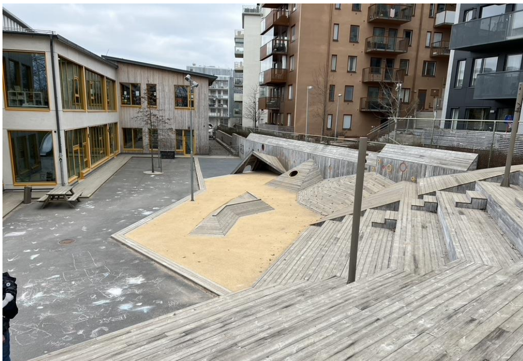
Figur 10. Vy över gårdens norra del. I framkant syns en väl tilltagen trappa där en fast konstruktion av solsegel är monterad. Längre bort syns klätterlek och två lekhus samt en planterad kärrek.
