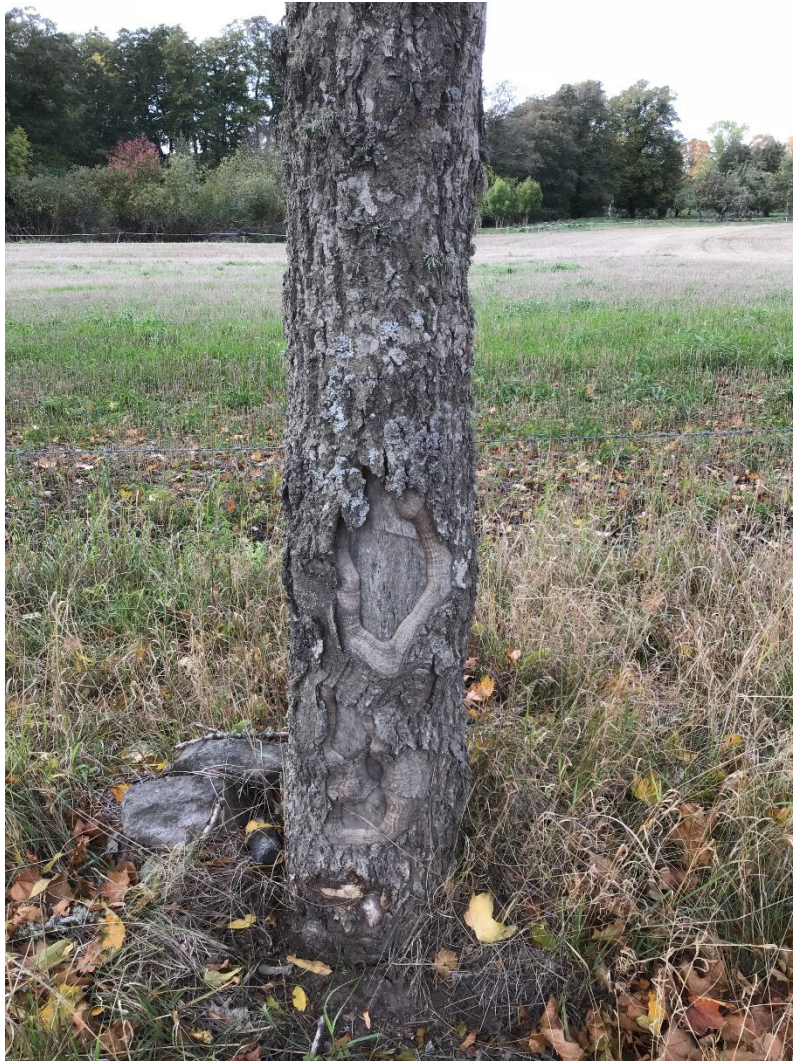
Figur 17. Stamskador orsakade av påkörningar av en lönn vid i Ledinge. Flera träd i allén är skadade av snöskottning och väggkantsröjningar. Foto Anna Westin.
