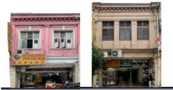
RAJAH 5. Fakad bangunan rumah kedai pada plot 3 dan 9 masih mengekalkan karakter dan elemen asal
