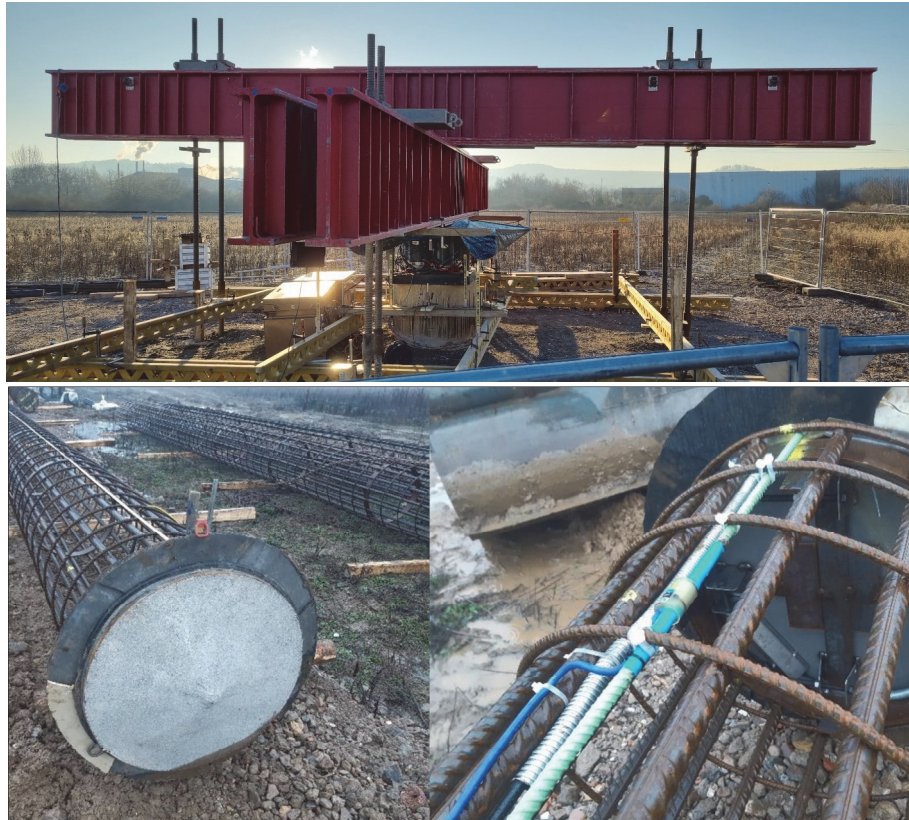
Bild 5 Oben: Foto der Belastungskonstruktion unten links: Druckkissen am Pfahlfuß, unten rechts: Sister Bar befestigt am Bewehrungskorb
