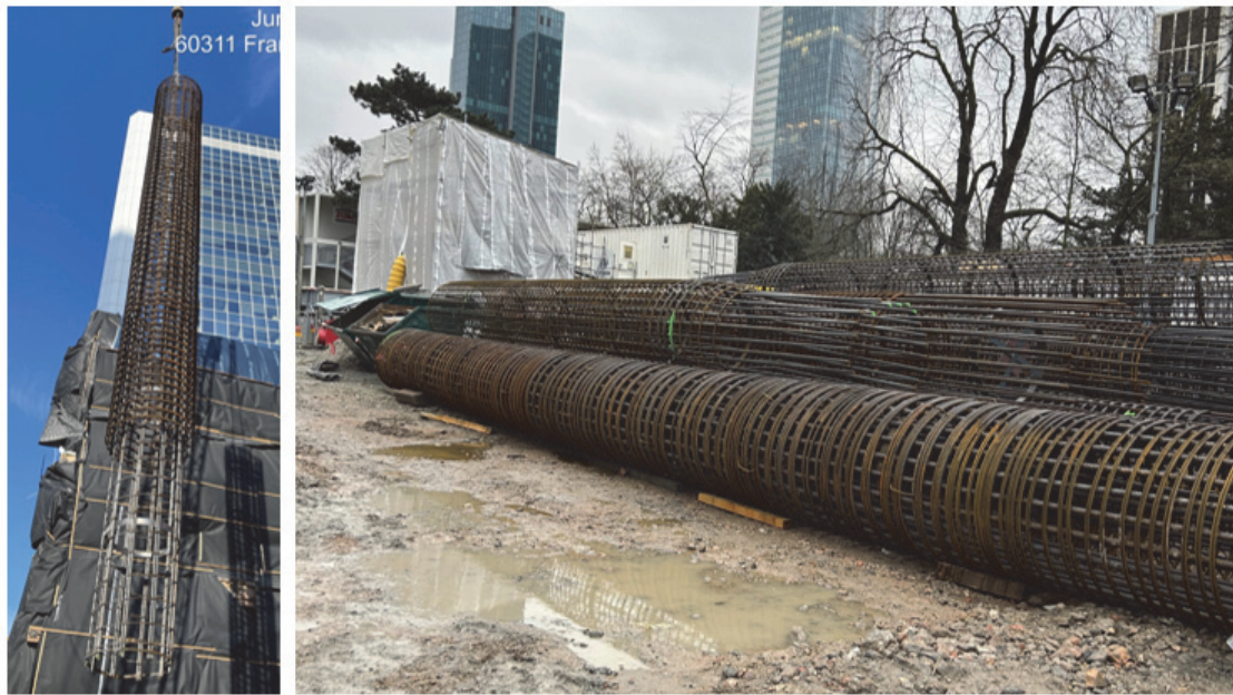
Bild 7 Massiv bewehrte Bewehrungskörbe beim CBT
