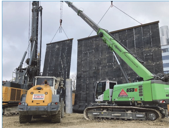
Bild 8 Arbeiten mit Lärmvorhang auf der Baustelle RS76 (Eigenes Foto ZÜBLIN Spezialtiefbau, 2023)
