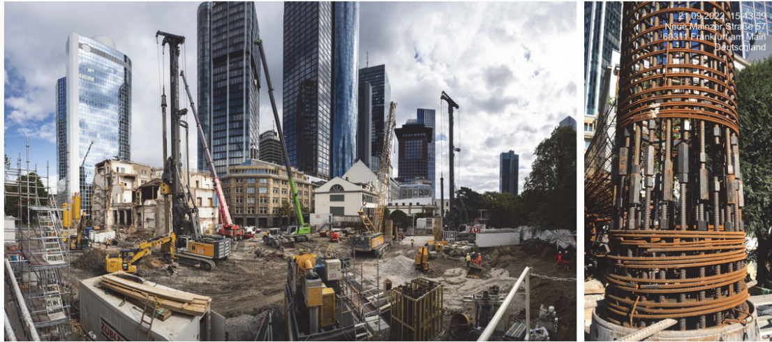
Bild 10 Links: Baufeld CBT bei der Bohrpfahlherstellung Rechts: „Muffenstoß“, Bewehrung für Verbau
