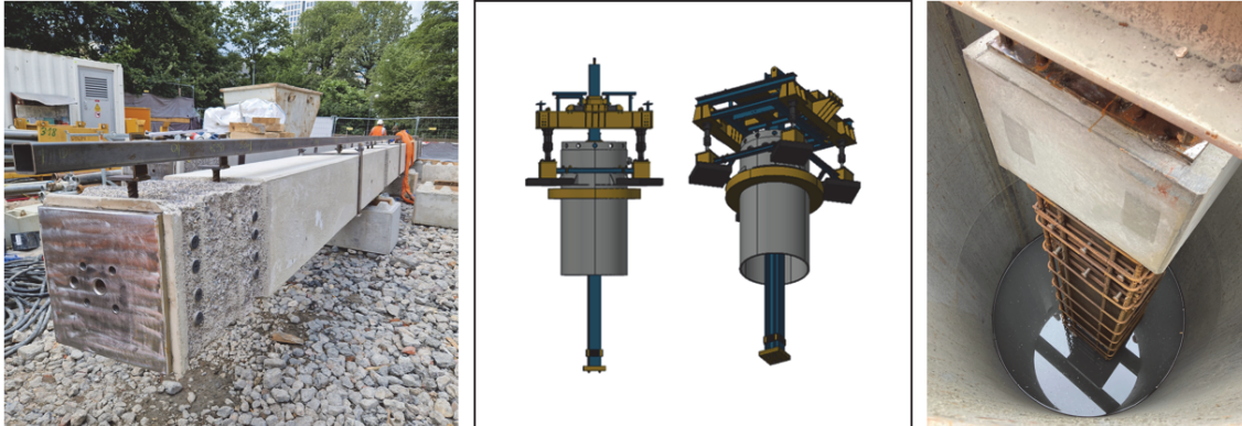
Bild 9 Links: Fertigteilstütze Mitte: Einbauvorrichtung für Primärstützen Rechts: eingebaute Verbundstütze
