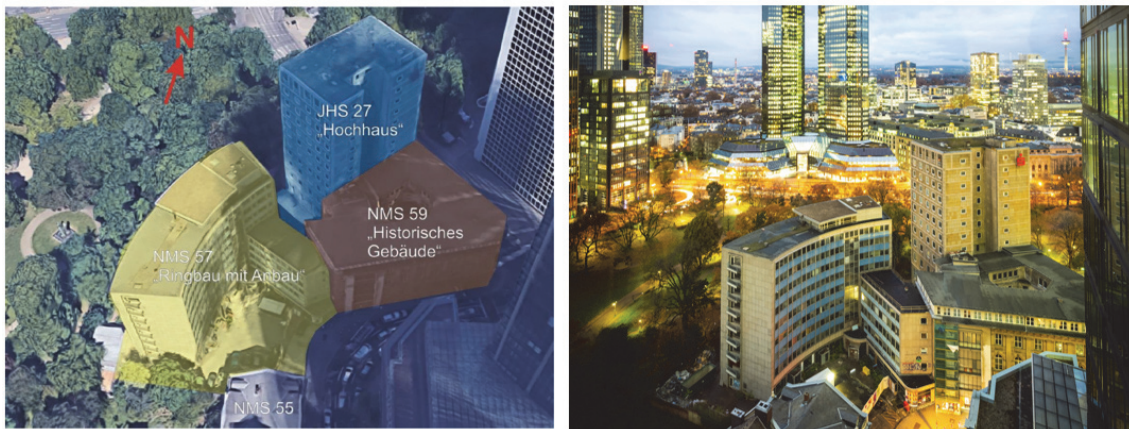
Bild 1 Grundstück Neue Mainzer Straße 57 der Helaba, vor dem Abriss
