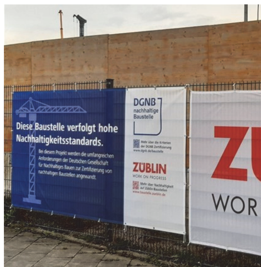
Bild 5 Baustellenbanner beim Projekt RS76 (eigenes Foto, 2023)
