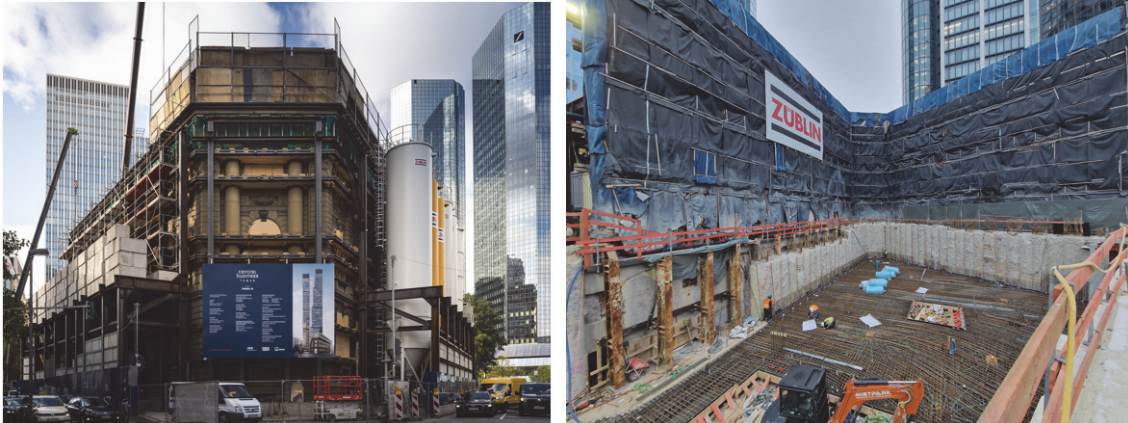
Bild 6 Links: Sicherung Bestandsfassade mit Stahlkonstruktion, Stand 08.2022 Rechts: Sicherung Fußbereich der Fassade, Stand 01.2024
