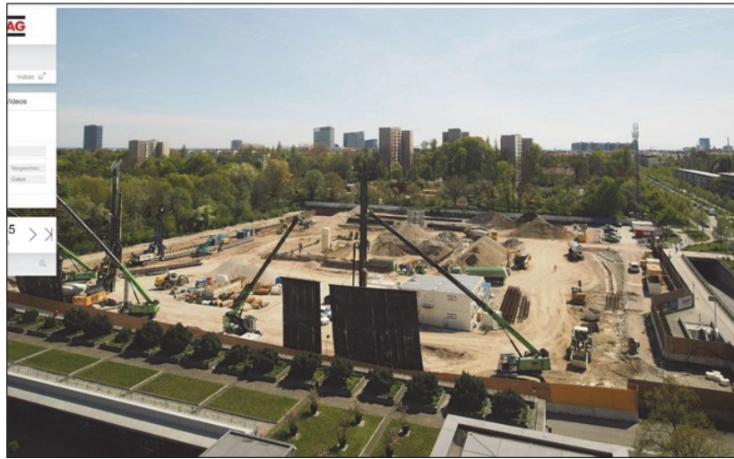
Bild 7 Übersicht über die Baustelle RS76 (STRABAG-Webcam, 2023)
