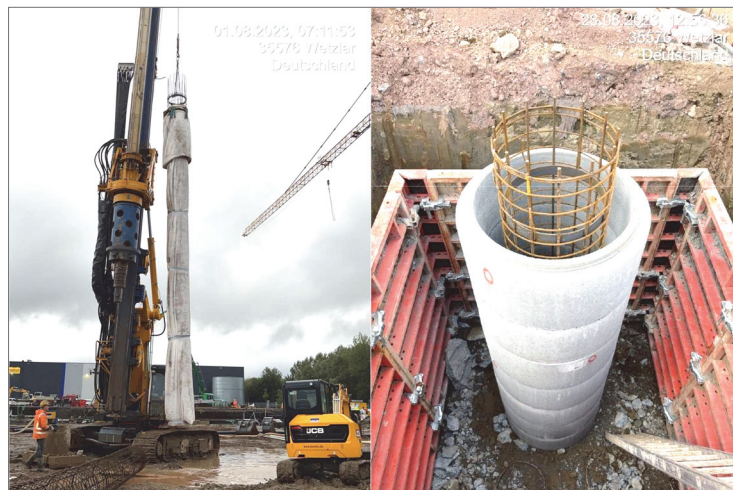
Bild 11 links: Einbau eines Bullflex-Hülsenschlauchs zur Reduzierung des Betonverlustes. rechts: Oberflächennahe Sanierung eines Bohrpfahls mittels Betonschachttringen (Quelle: ARGE DEMLER & GBS)
