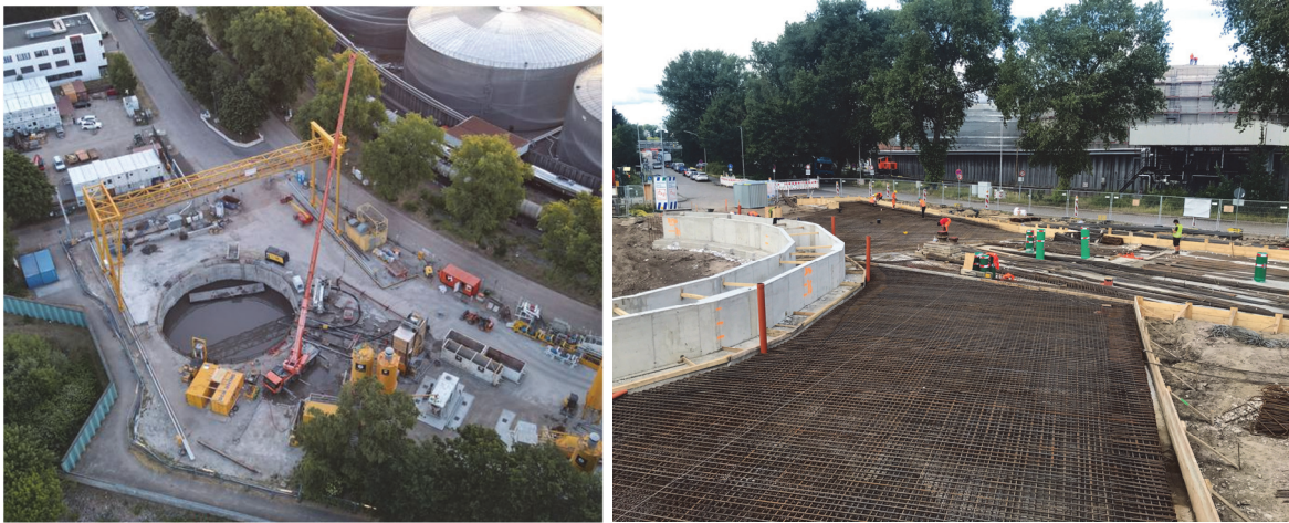
Bild 5 Lastverteilende Betonplatten BE-Fläche Süd
