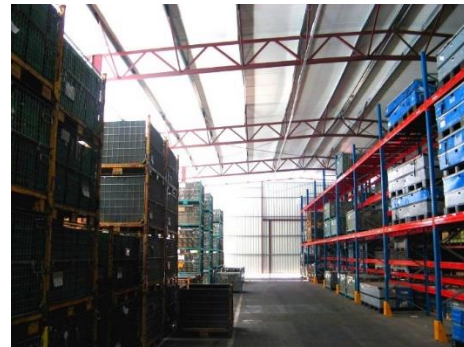
Ilustración 105: Interior de una nave Industrial. Recuperado de: https://www.patec.org/naves-industriales.php
