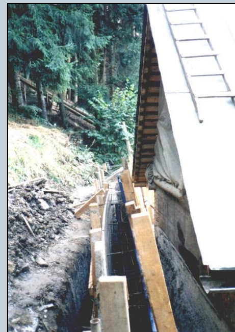
Halenkov – u Kopeckých – provádění mikropilotové stěny ve stísněných podmínkách za domem (10/1998)
