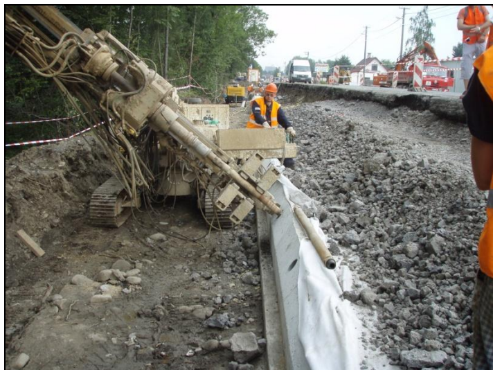
Silnice I/11 Vendryně – opěrná zed' (mikropiloty a kotvy) – 09/2010
