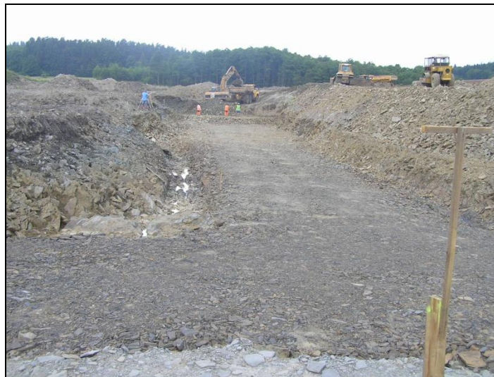
Retenční nádrž Lichnov – základová spára sdruženého objektu (07/2011)
