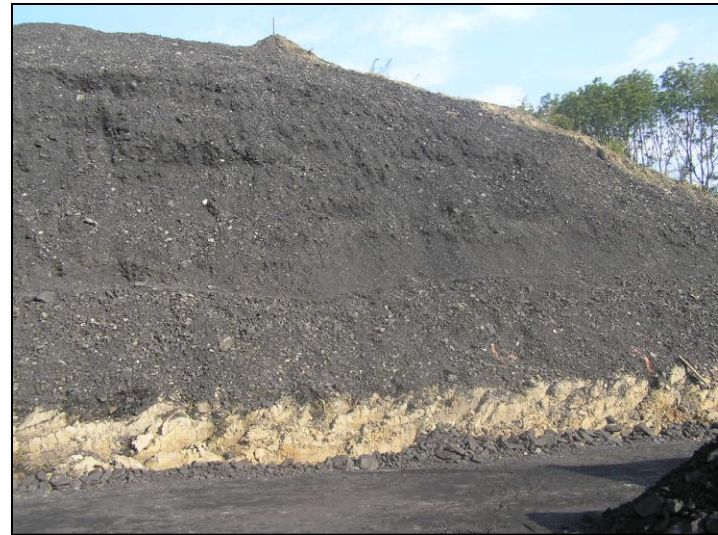
Silnice I/56 Ostrava – Prodloužená Místecká ul, násyp s konsolidační vrstvou u SO 207
