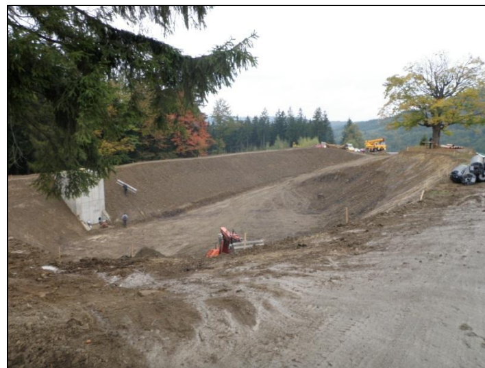
Zasněžovací nádrž Javor – hráz z vyztužené zeminy (10/2009)
