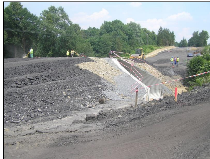
Silnice I/48 Rychaltice – Frýdek-Místek – plošně založený tubosider v km 1.620 obslužné komunikace
