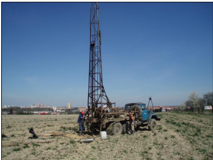
Průzkumný vrt pro stavbu logistického centra Prologis v Ostravě - Porubě
