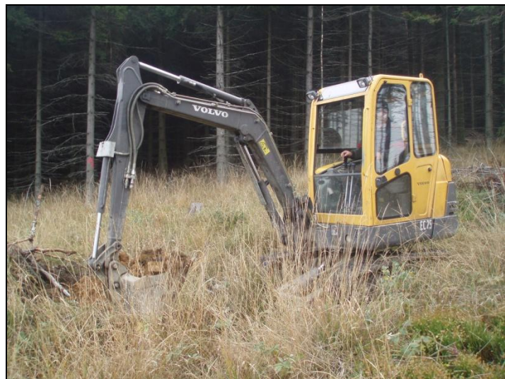
Kopaná sonda na Prašivé pro průzkum základových poměrů základnové stanice RDTF sítě
