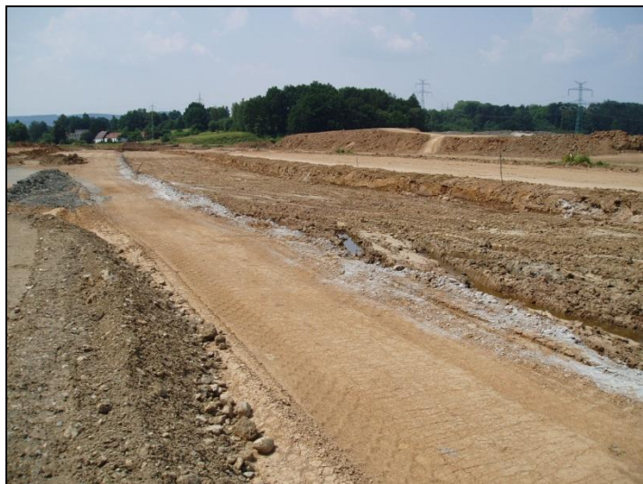
Žichlínek – polder – těsnící jádro hráze (06/2008)
