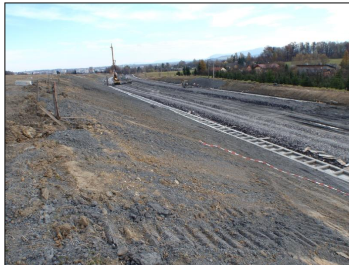
Silnice I/48 Rychaltice – Frýdek-Místek, zárubní zeď SO 252 budovaná z velkopřůměrových pilot (10/2010)
