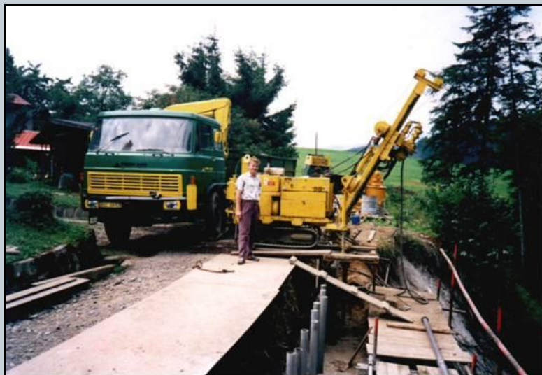
Horní Bečva – Mšadlý potok, provádění mikropilot na kraji místní komunikace nad srázem (08/1998)
