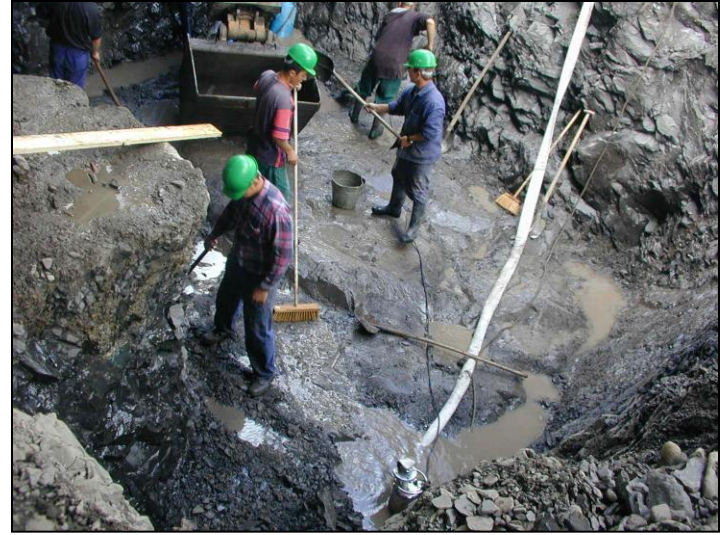
Třinec – “myší díra“ – čištění základové spáry mostu. Základová spára je tvořena vápenci křídového stáří (05/2001)
