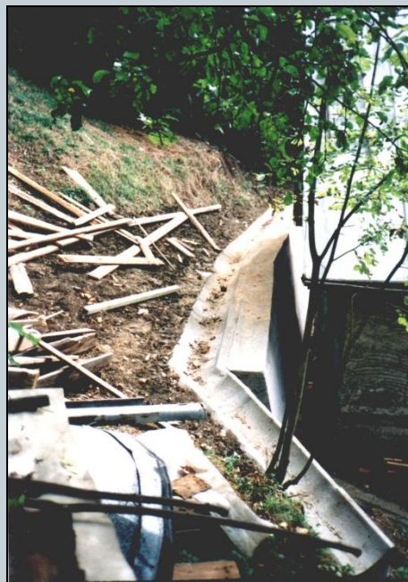
Halenkov – u Kopeckých – provádění mikropilotové stěny ve stísněných podmínkách za domem (10/1998)
