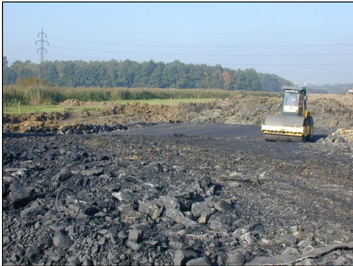
Silnice I/48 Dobrá - obchvat, konsolidační vrstva z hrubozrnné uhelné hlušiny
