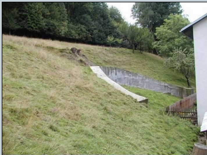
Zubří – Vičanovi, betonová tížná zeď klenbového tvaru (stav 05/2005)
