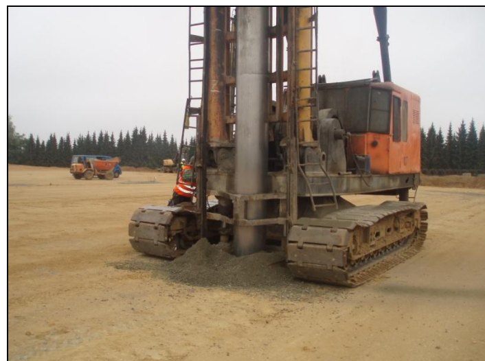
Ostrava – Poruba – Prologis – zakládání haly na FRANKI pilotách
