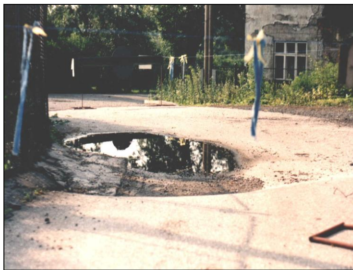
Orlová – propad silnice vlivem poddolování
