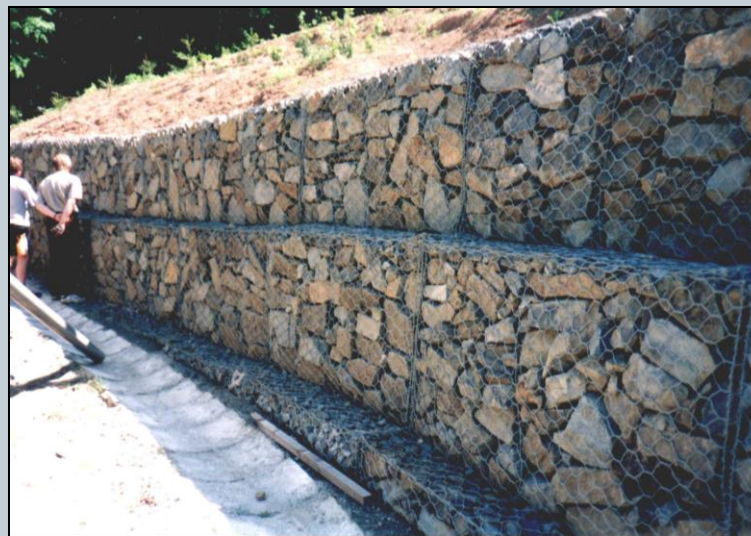
Jablůnka - gabionová stěna nad RD p. Svobody (06/2000)
