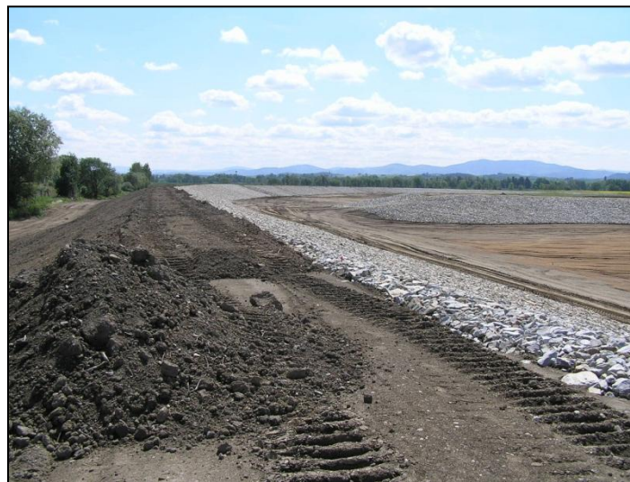
Javorník ve Slezsku – multifunkční nádrž - hráz s protierozní ochranou návodní strany (07/2009)
