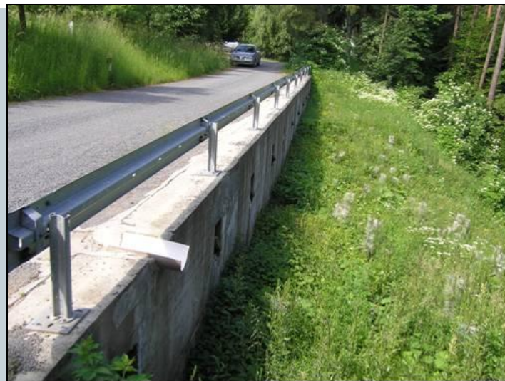
Huslenky – Hřebík, mikropilotvá stěna kotvená lanovými kotvami zajišťující místní komunikaci (06/2005)
