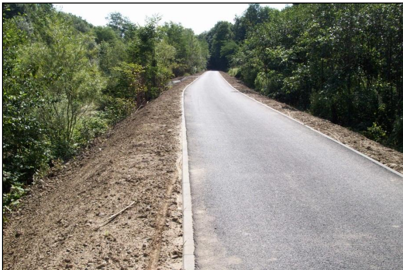
Protipovodňová hráz s cyklostezkou - Valašské Meziříčí (09/2010)
