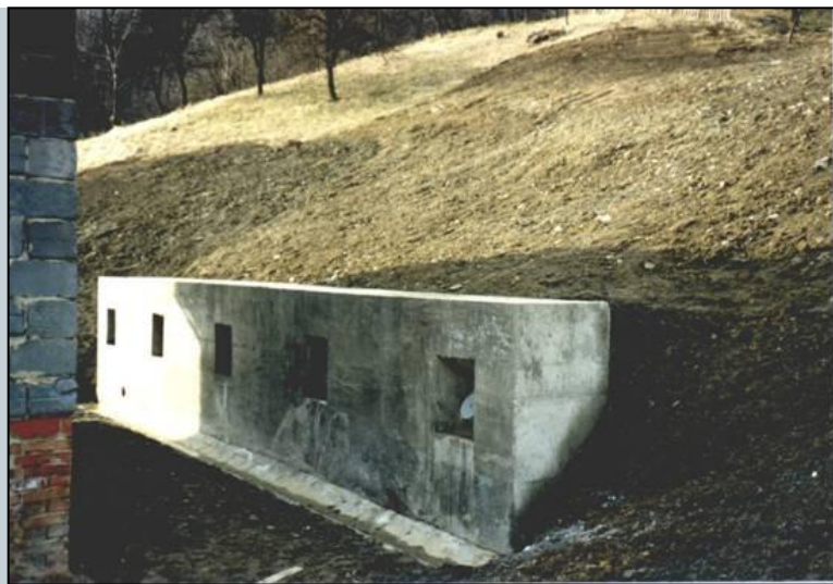
Valašské Meziříčí – Poličná, Kotlina, kotvená tížná betonová zeď za rodinným domem p. Mžika (03/1999)
