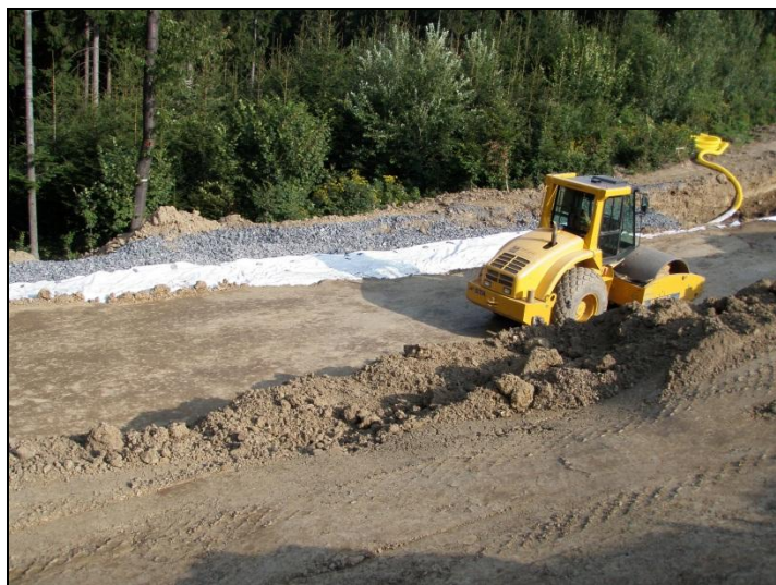
Zasněžovací nádrž Javor – výstavba kamenné paty (07/2009)
