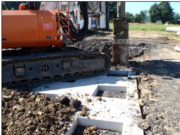
Silnice I/48 Rychaltice – Frýdek-Místek, most SO219, vrtání velkopřůměrových pilot (07/2010)
