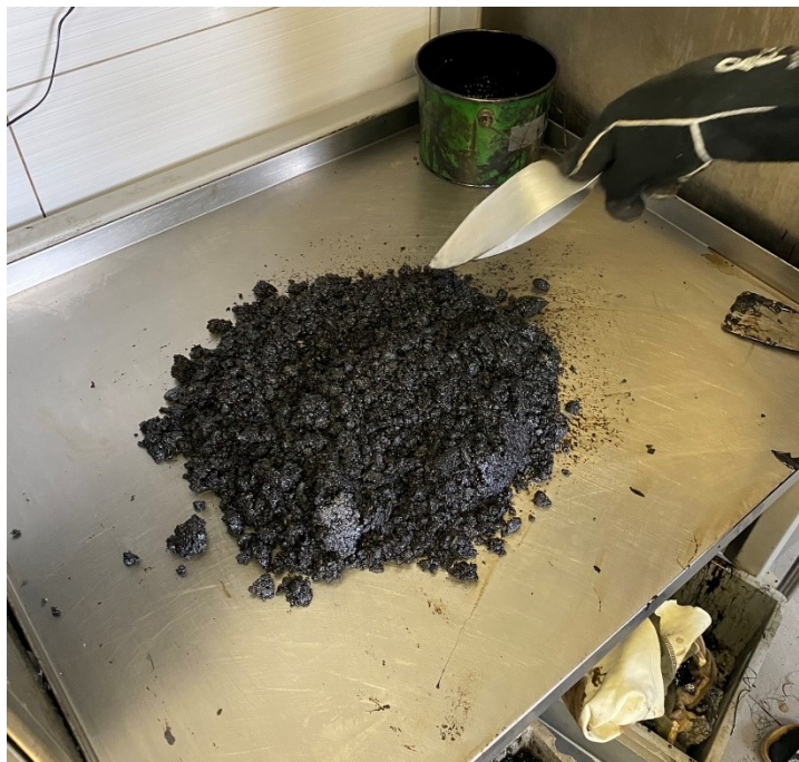
Obrázek 14 – rozprostřená asfaltová směs na určené ploše
