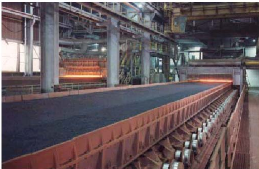
Obr. 15 Fotografie spékacího pásu se zavázcím zařízením (bubny nebo skluznými žlaby) a zážehovým krytem na začátku pásu [IPPC]
