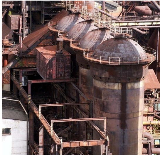
Obr. 23 Příčný řez ohřivači větru s vnitřní a vnější ohřivací komorou [IPPC] a pohled na ohřivače větru
