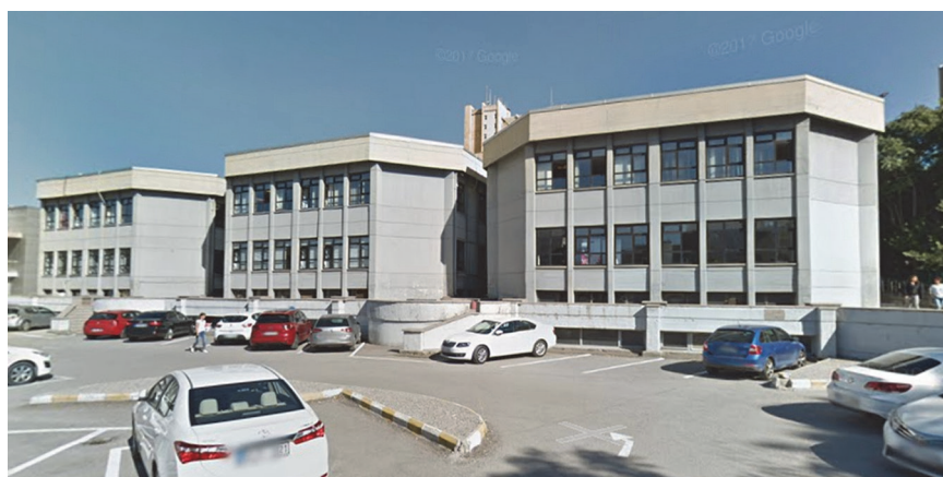
Slika 2. Vanjski izgled zgrade
