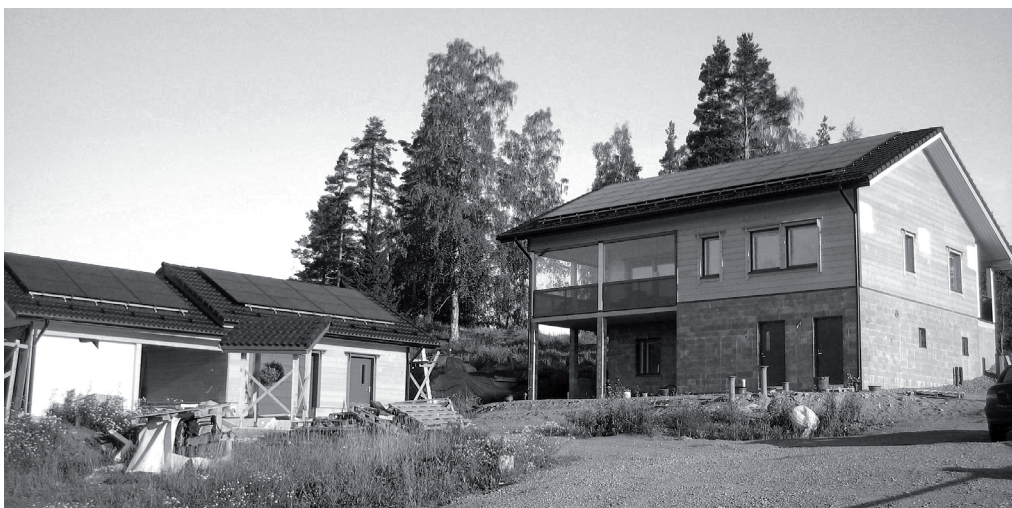
Aurinkopaneeleja katon etelälapeella haja-asutusalueella sijaitsevassa uudiskohteessa.
