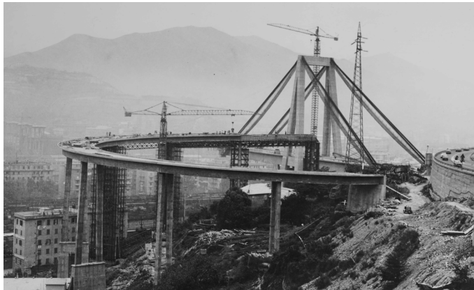
Figure 23. Construction work on the helical ramp (1963-67)/ Lavori di costruzione della rampa elicoidale (1963-67).
