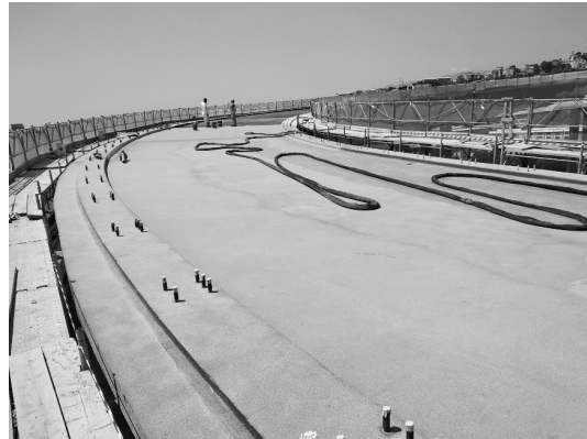
Figure 19. Waterproofing of the deck / Impermeabilizzazione dell'impalcato.
