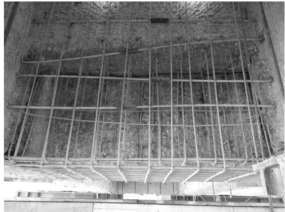
Figure 10. Intervention of solidarity in the half-joint / Intervento di solidarizzazione selle gerber.
