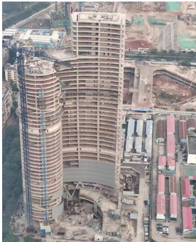
図 5-9 建設中の I Carbon building
