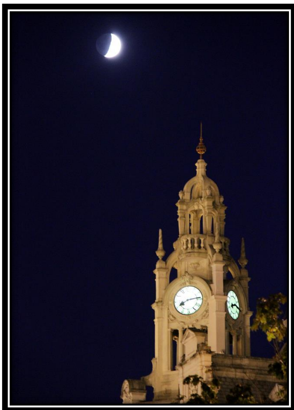
Figura 47.1.: Topo do edifício onde funcionou o jornal O Comércio do Porto , na Avenida dos Aliados, edifício 109.
