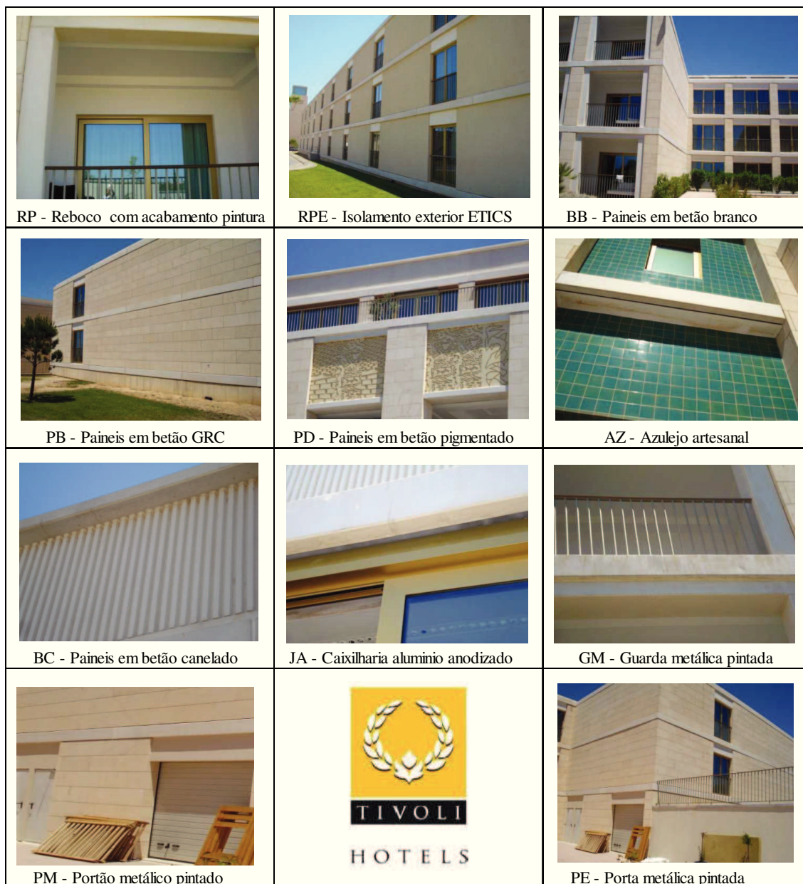
Figura 5.6 – Elementos fonte de manutenção da fachada do edifício em estudo
