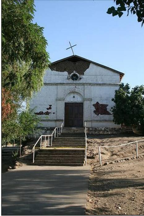
Figura 6.0. Santuario en Pencahue, Talca, con daños menores y no estructurales tras el sismo de 8.8 grados ocurrido en 2010 en el mar de Chile, frente a las localidades de Curanipe y Cobquecura.
