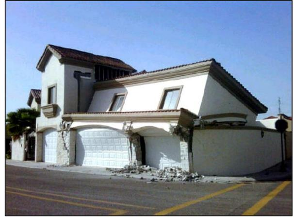
Figura 5.0. Vivienda con daños en miembros estructurales tras un sismo de 7.2 grados en Baja California, México.
