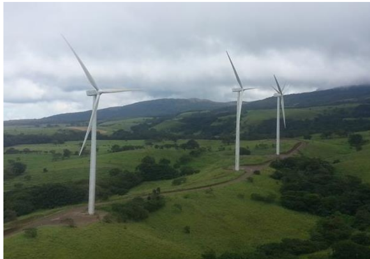
Figura 3.15 Aerogeneradores de eje horizontal y tres palas
