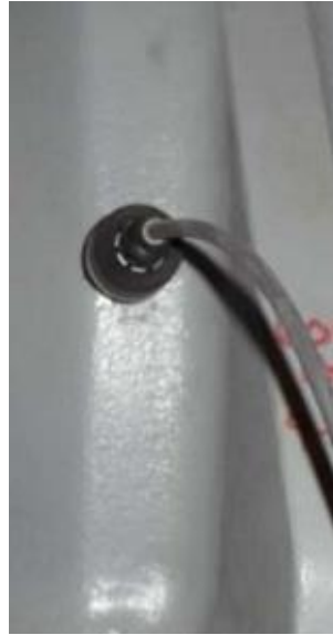
Figura A8.29 Colocación de acelerómetro para el rodamiento principal, posición radial
