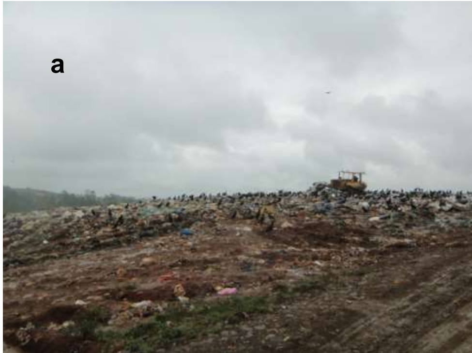
Anexo 7. Vertedero municipal San Luis de Florencia, San Carlos. a) Disposición de los residuos en el Vertedero, b) lixiviados del Vertedero
