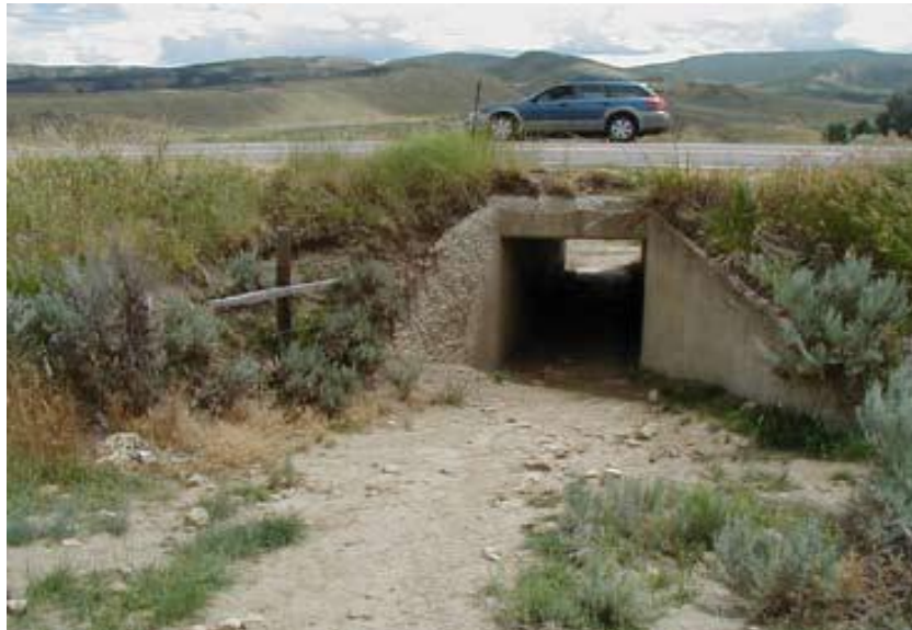
Figura 17. Paso subterráneo recomendado para mamíferos pequeños, anfibios y reptiles elaborado con tubos de concreto.
