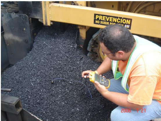
Figura 9. Medición de la temperatura al momento de colocar la mezcla modificada.
