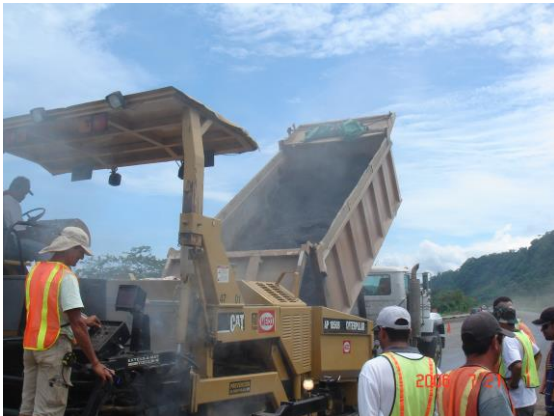
Figura 8. Elaboración del paño de prueba de la mezcla modificada con látex UP70SBR.
