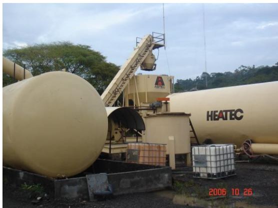
Figura 2. Tanque de almacenamiento del combustible y depósito de almacenamiento del látex.
