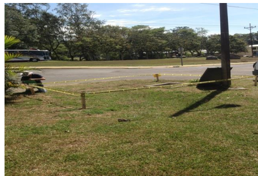
Imagen 4. Área de trabajo en Escuela de Producción Industrial, edificio de oficinas.
