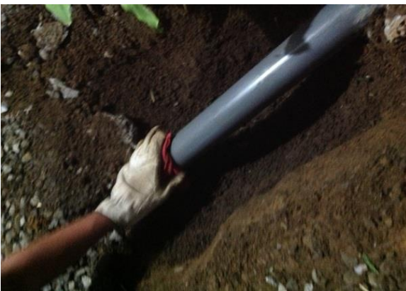
Imagen 6. Limpieza de tubería de PVC de 50 mm en Condominio Veranda, Curridabat.
