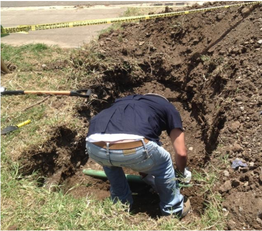
Imagen 5. Trabajos de excavación en Escuela de Producción Industrial, edificio de oficinas.
