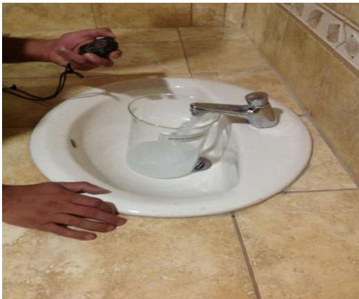
Imagen 2. Aforo de lavatorio del centro educativo.
