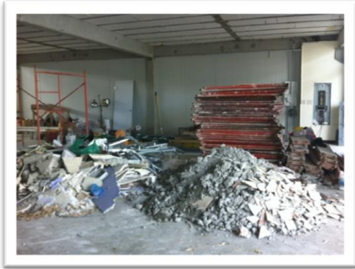
Figura 21. Almacenamiento de escombros, escaleras y cuerpos de andamio.
