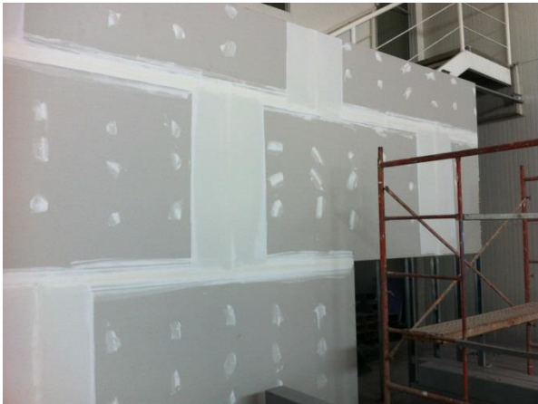
Figura 12. Colocación de lámina de gypsum
