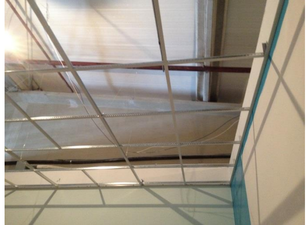
Figura 13. Estructura de cielo suspendido
