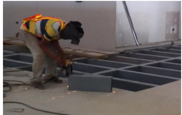
Figura 10. Corte de perfiles con esmeriladora
