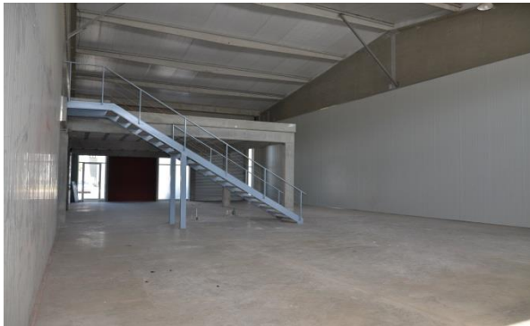
Figura 6. Bodega D3 previo al inicio de la remodelación.
