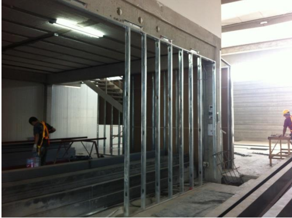
Figura 11. Estructura de paredes livianas.
