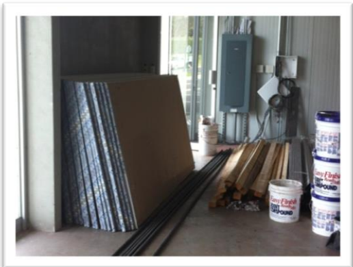
Figura 22. Materiales para paredes livianas.
