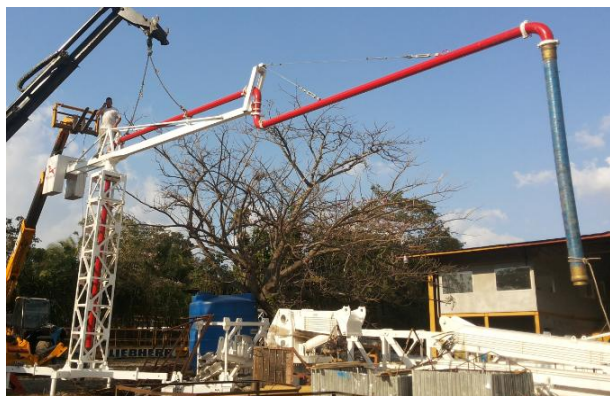
Figura 14: Colocador mecánico de concreto. Fuente: Elaboración propia
