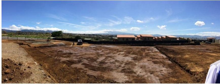
Anexo 1. Imagen del estado inicial del sitio.
