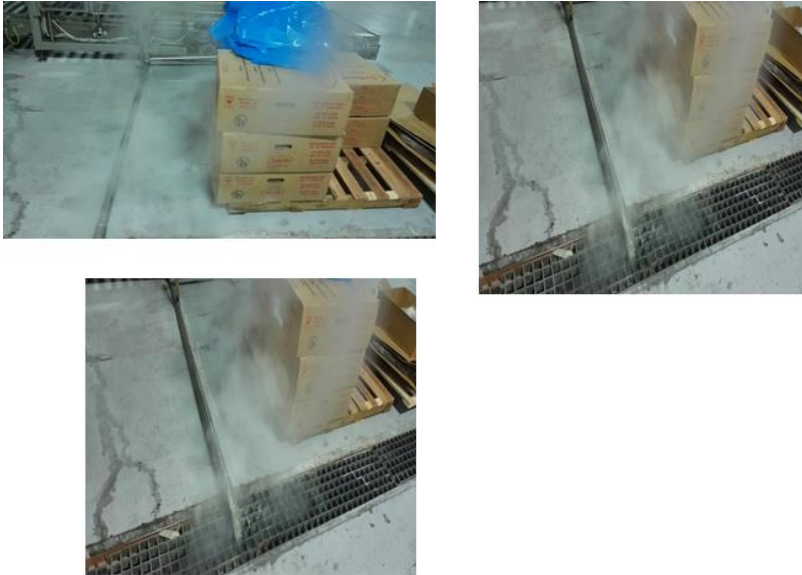
Figura 9.1.5-1. Situación actual del retorno de condensado de la llenadora de puré de banano. Fuente: Fotografía tomada en Frutilight.
