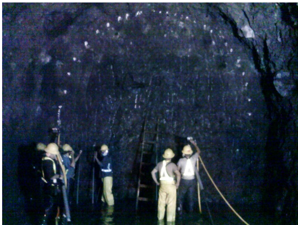
Figura # 31. Proceso de perforación del frente con el método de perforación y voladura (convencional). (PHBI, 2012).
