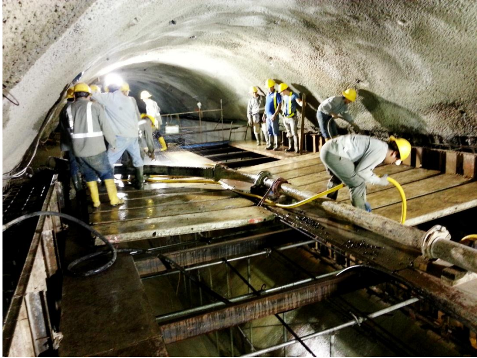
Figura # 28. Colado de muros del túnel del desgravador 1. (PHBI, 2012).
