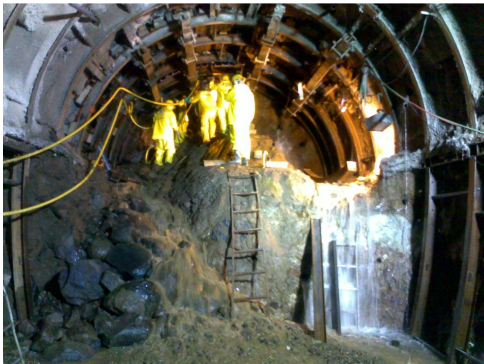
Figura # 30. Proceso de excavación bajo en el método manual. (PHBI, 2012).
