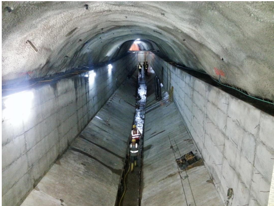
Figura # 29. Obras del túnel del desgravador 1 cerca de su finalización. (PHBI, 2012).
