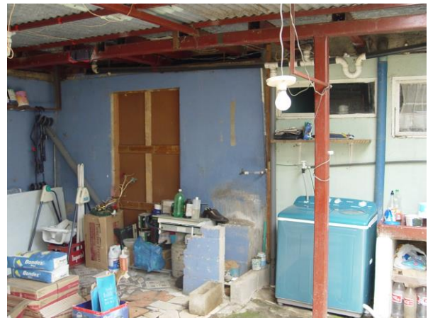
Figura 9. Sector de pilas de una de las viviendas tipo de las urbanizaciones de Ipís. (Programa: Paint)
