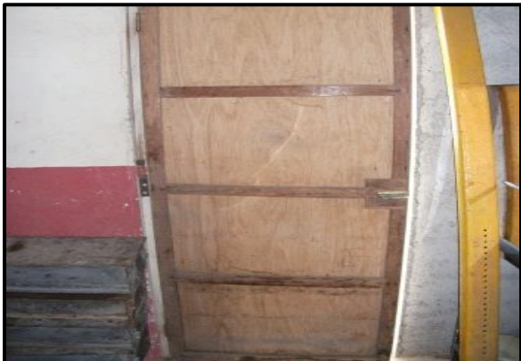
Figura 4. Puerta posterior, vista interior.
