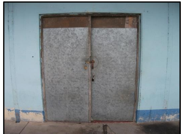
Figura 1. Puerta principal, vista exterior.
