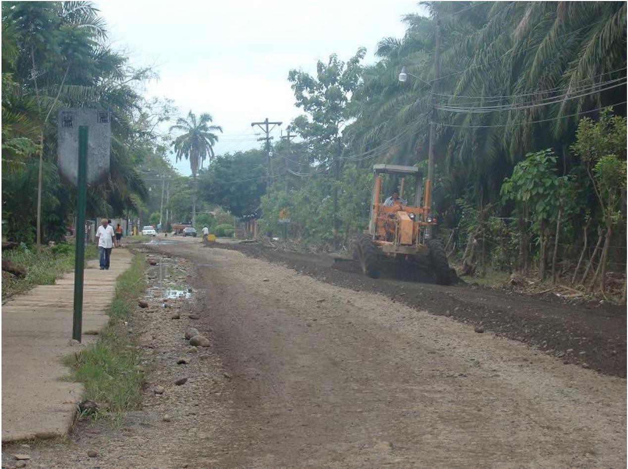
Fotografía del mantenimiento de vías o rutas de acarreo.
