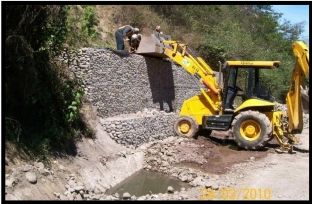
Cauce revestido con toba cemento plástico
