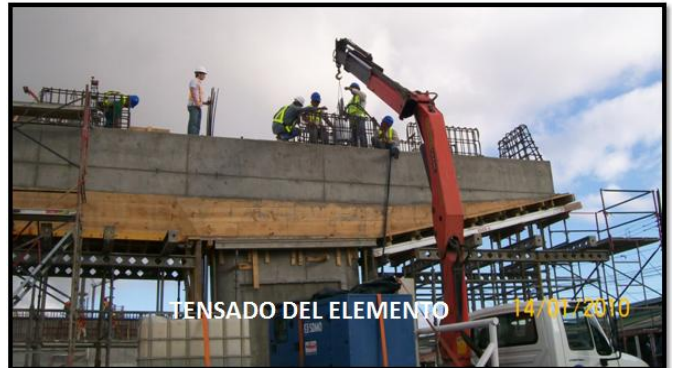
Elementos estructurales preesforzados viga cabezal de pila clase D(1)f'c 420kg/cm 2 .
