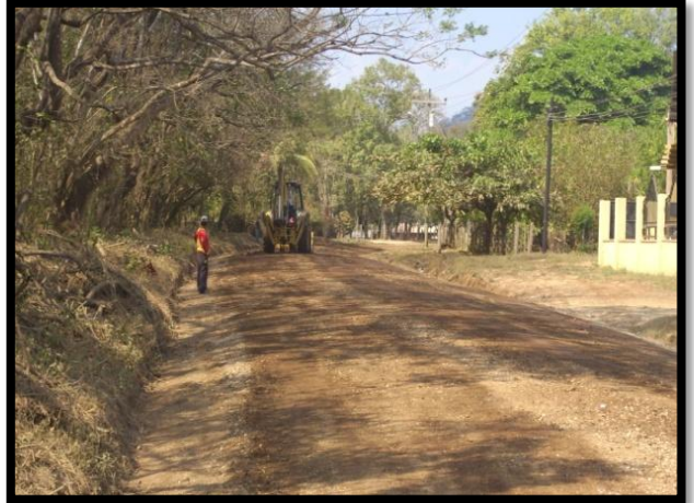
Conformación de calzada
