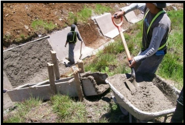
Cauce revestido con toba cemento plástico
