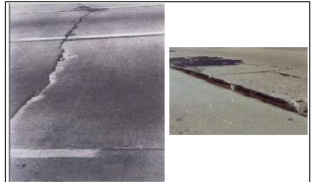
Figura 35. Escalonamiento entre losas o trozos de losas (DIRCAIBEA, 2000).
