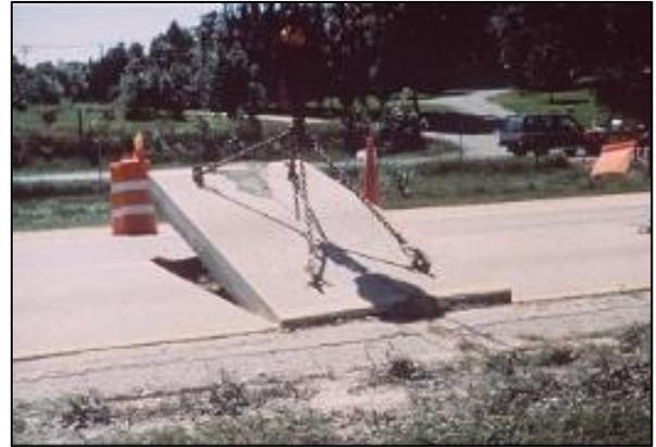
**Figura 70.** Remoción de losas en pavimentos de concreto (FHWA).
