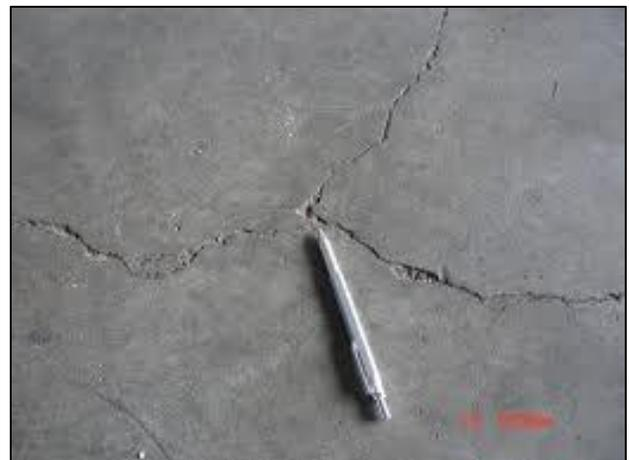
Figura 23. Grietas inducidas (<http://enconcreto-mf.blogspot.com>, 2013).
