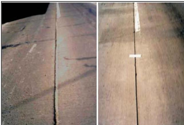
Figura 15. Separación de la junta longitudinal (DIRCAIBEA, 2000).
