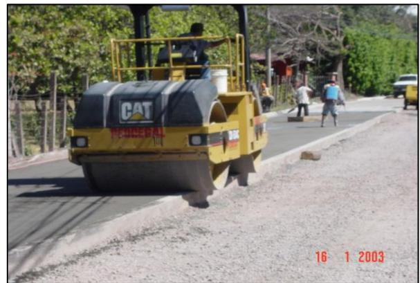
Figura 75. Compactador vibratorio.
