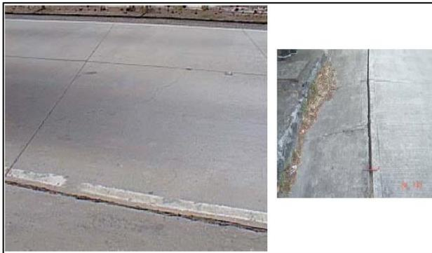
**Figura 39.** Separación de la berma y el pavimento (DIRCAIBEA, 2000).
