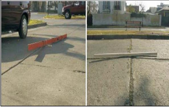
Figura 33. Levantamiento localizado (DIRCAIBEA, 2000).
