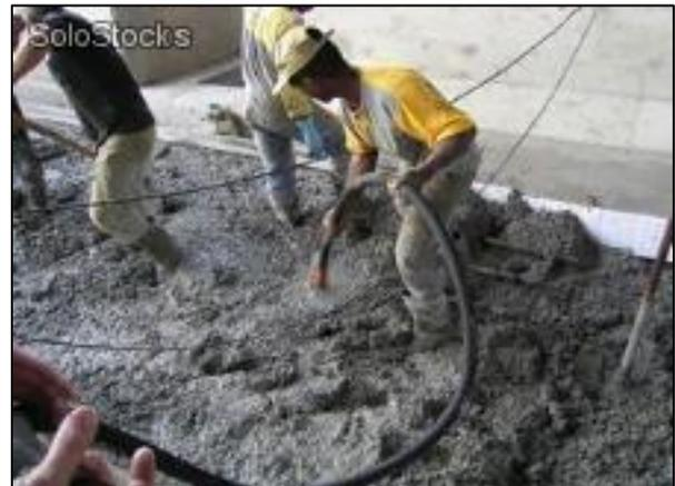
Figura 76. Vibrador de concreto.
