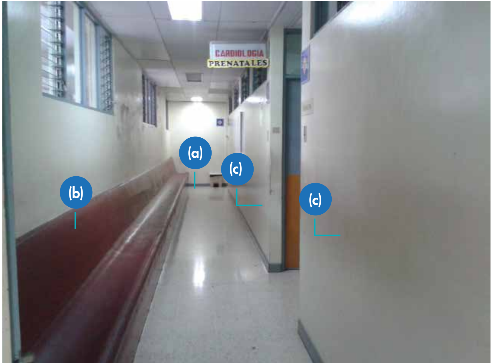
Figura 34_ Problemas / área gineco obstetra 1
