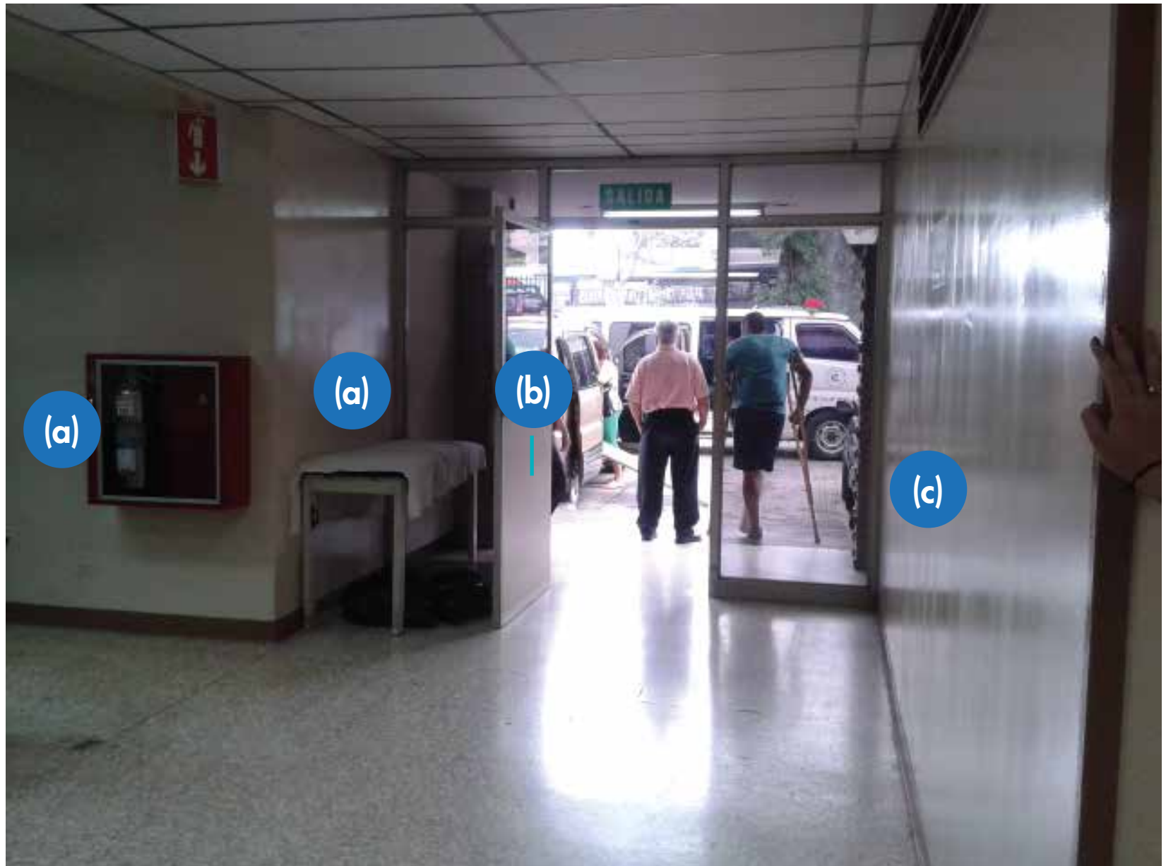
Figura 39_ Problemas / área emergencias 2
