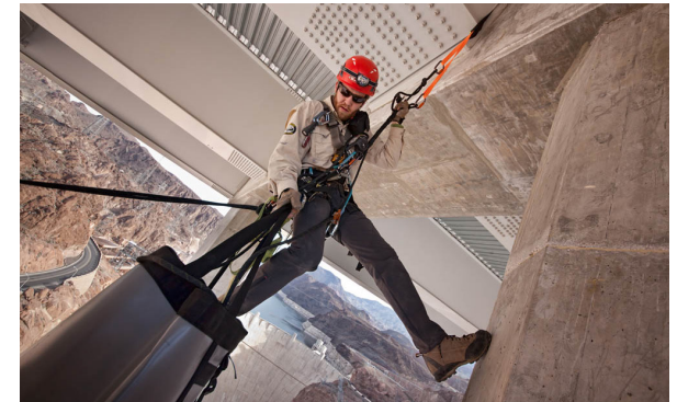
Imagen3. Inspección de puentes por medio de cuerdas.
