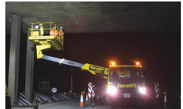
Imagen4. Inspección de puentes utilizando gruas.
