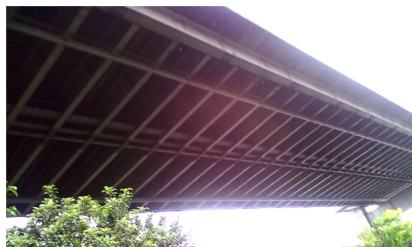
Imagen43. Vista de puente
