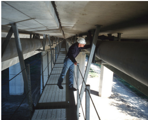
Imagen5. Inspector de puentes
