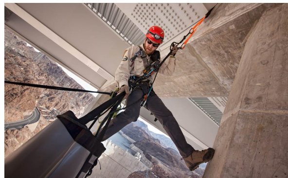
Imagen9. Inspección por cables
