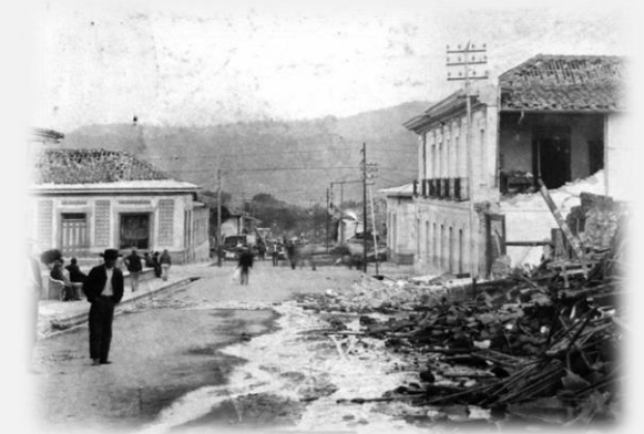
Ilustración 16: Costado norte del Edificio Pirie, Fuente: Colección Jorge Valverde (1910)
