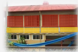
Ilustración 29 Ritmo en interior y exterior de Casa de la Ciudad.
