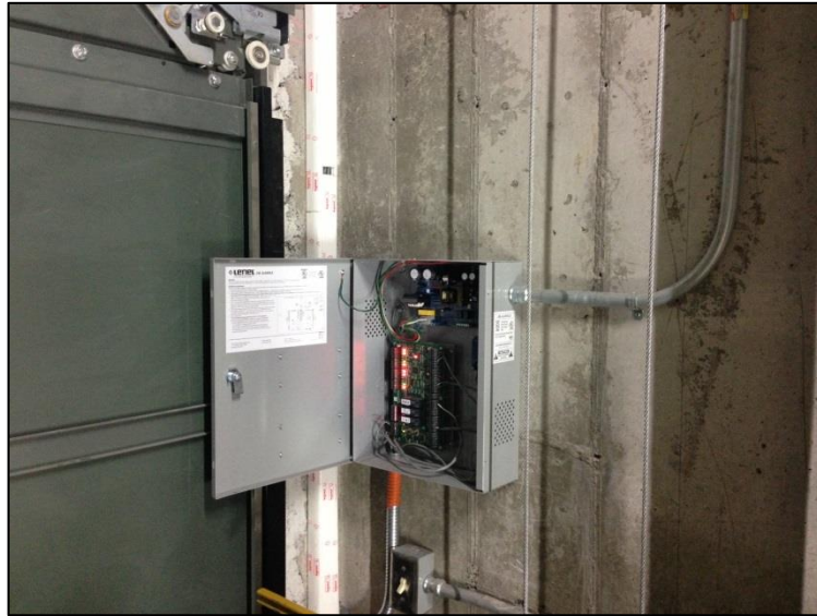
Figura 4.2.1.2. Ubicación del panel Lenel dentro de la fosa del elevador
