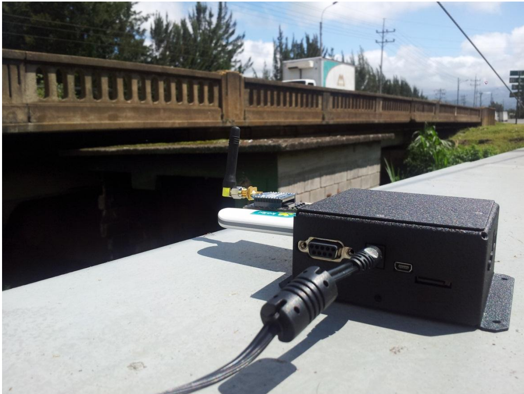
Figura 44 Sistema diseñado realizando pruebas en el puente
