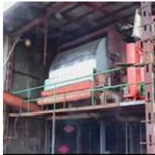
Figura #6 Clarificación y Filtración.
