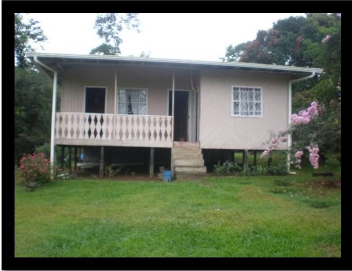
Casa de Habitación
