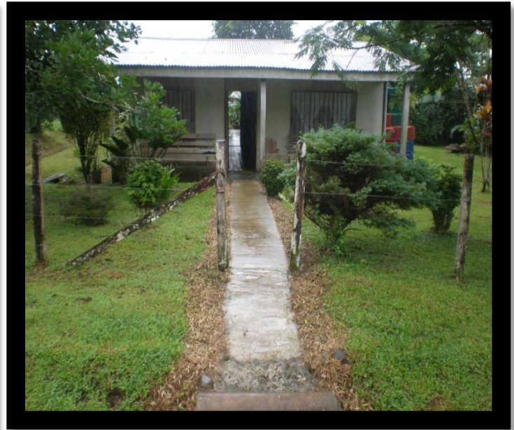
Casa de Habitación
