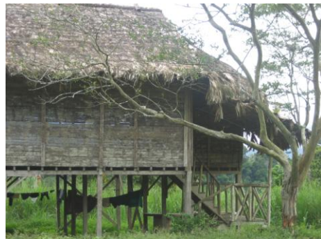
Fig. 4. Estructura tradicional en Suretka. Fuente Propia
