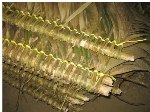
Fig. 2. Tejido tradicional de las hojas de suita para la cubierta. Fuente Propia
