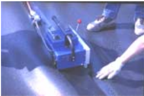
Proceso de soldadura por cuña caliente
