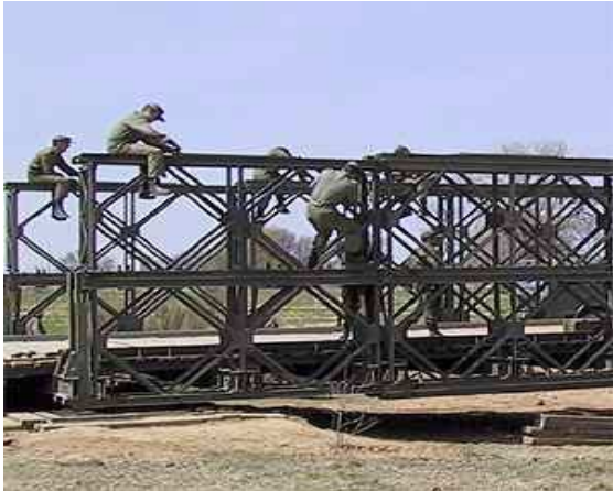
Fig. N° 4: Instalación de un puente de metal prefabricado MSPAINT
