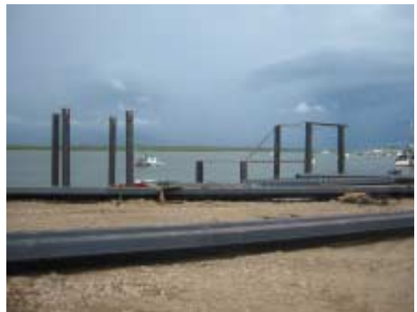
Fotografía 7: Terminal de transbordadores en construcción
