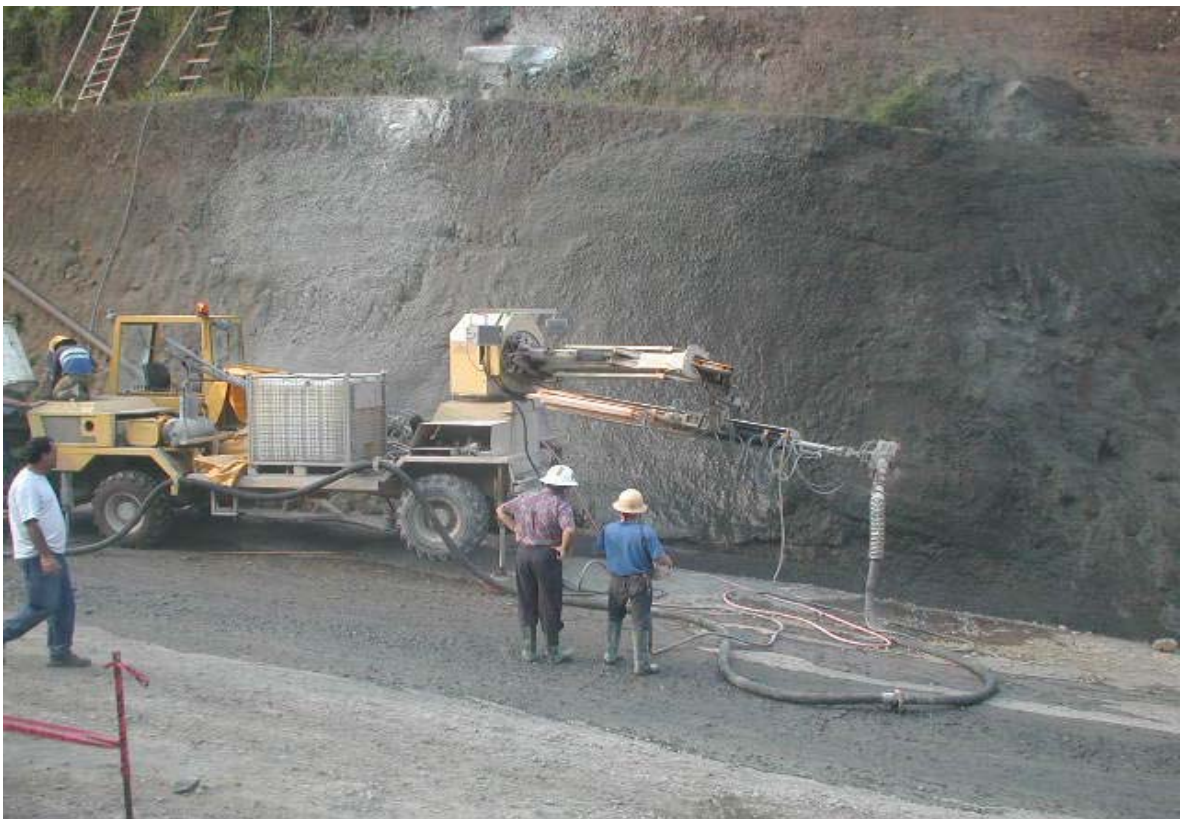
Figura 3. Colocación de concreto lanzado.
