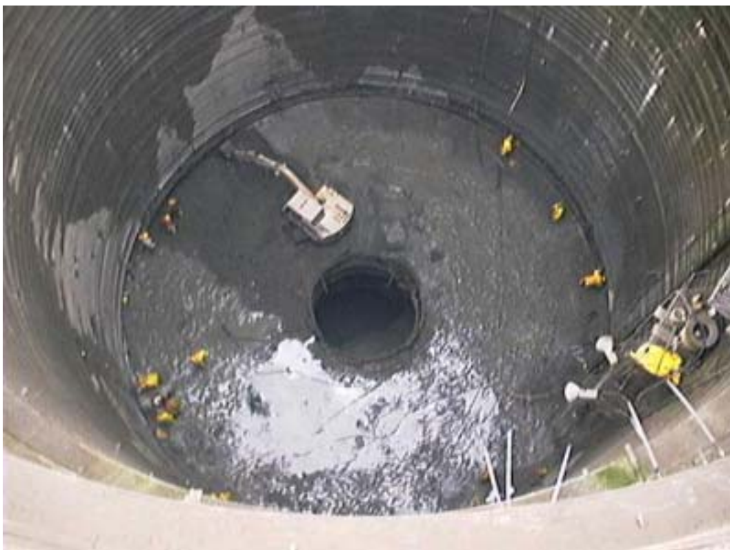
Excavación del Pozo Principal
