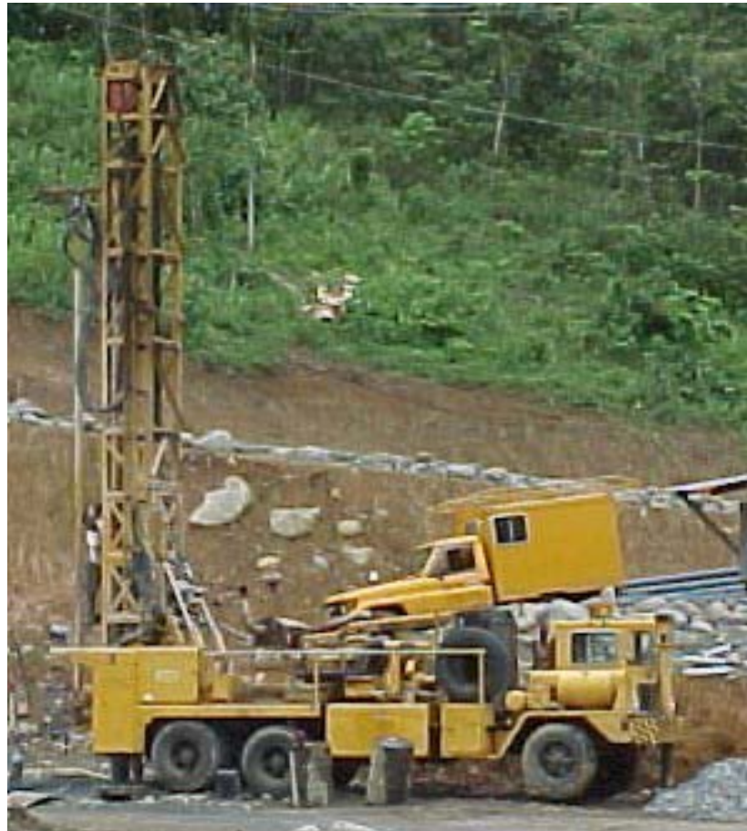
Perforaciones para Pilotes Preexcavados
