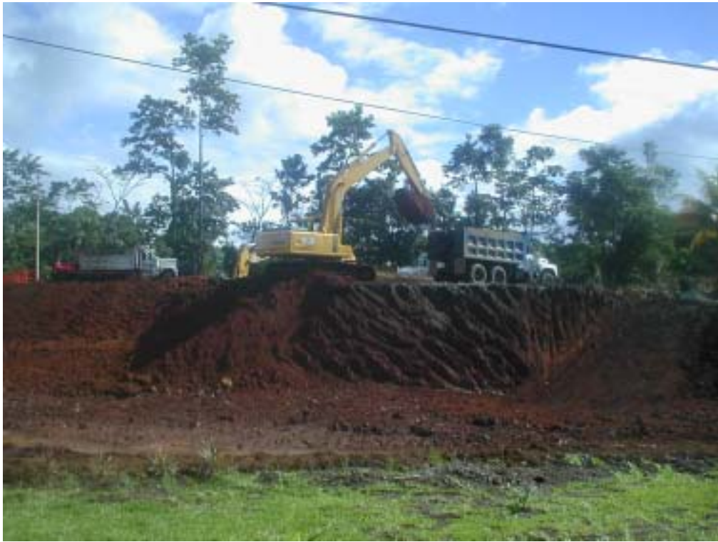
Inicio de Excavación
