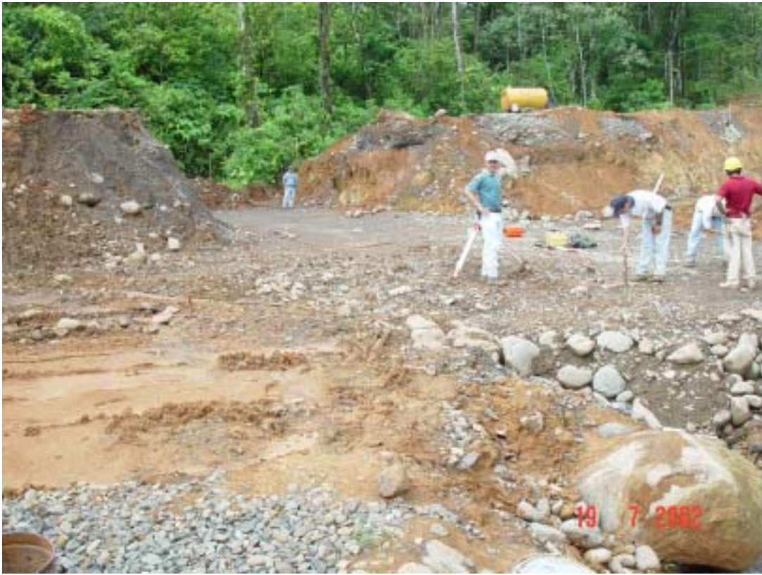
Trabajos de Topografía
