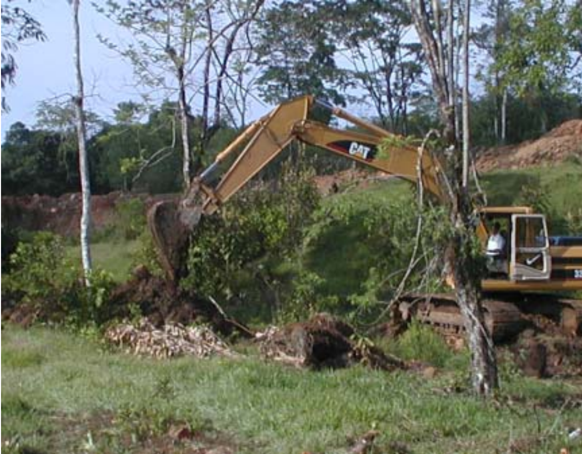
Trabajos de Limpieza y Desmante
