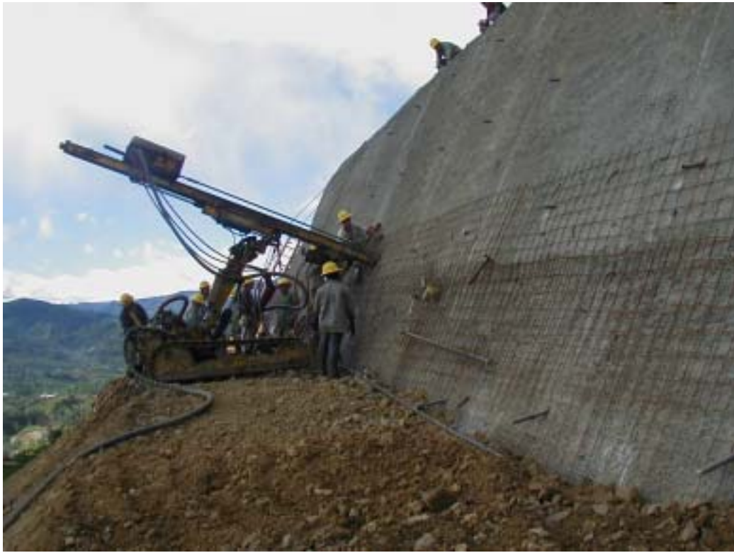
Perforaciones para Pernos Pasivos
