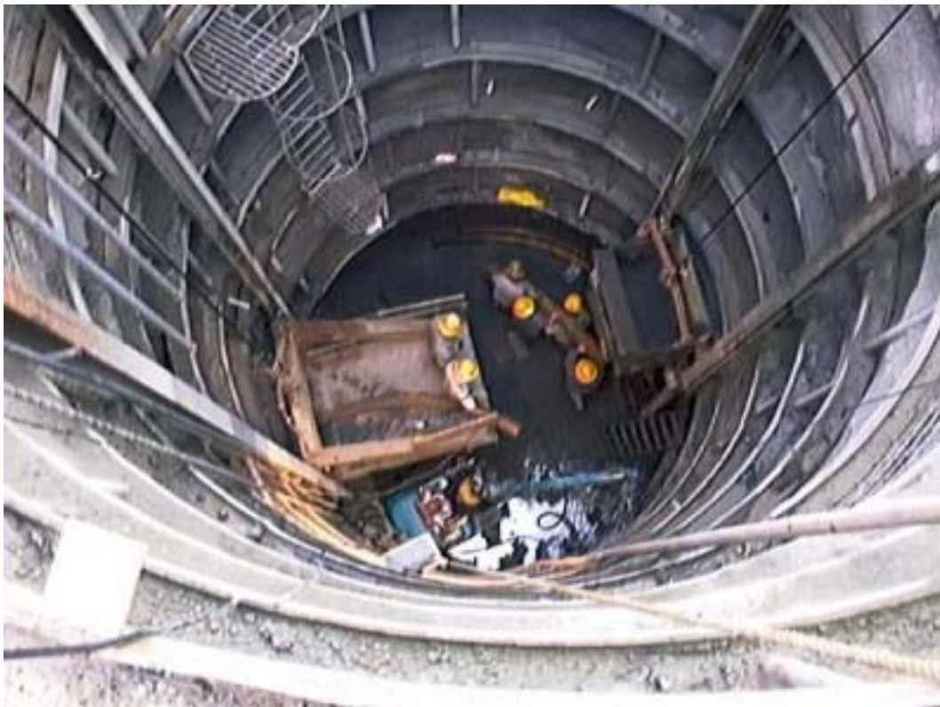
Excavación del Pozo Piloto
