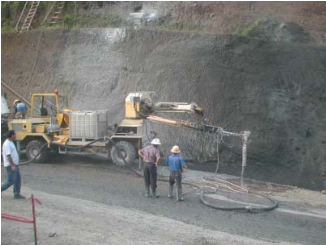
Colocación de Concreto Lanzado
