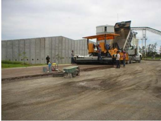
Figura 32. Movimiento en conjunto de la maquinaria para la colocación de la mezcla de CCR
