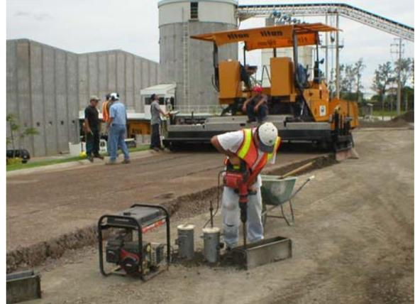
Figura 2: Etapa 4, prueba escala natural, colocación en situ de las mezclas probadas en el laboratorio.
