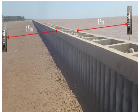
Hình 2. Bố trí các sensor đo sóng
