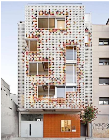
Hình 16. Mặt đứng nhà phố ở Barcelona (Arquitectes, 2022)
