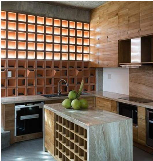
Hình 29. Sử dụng gạch thông gió làm các ô cửa thông gió, chiếu sáng trong công trình (Chiên, 2018)
