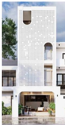
Hình 25. Gạch thông gió với nhiều thủ nghệ thuật bố cục kiến trúc (Công ty Cổ phần phát triển Wedo, 2022)
