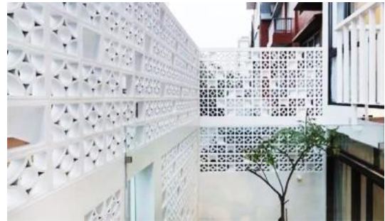
Hình 13. Mặt đứng công trình sử dụng gạch thông gió (Big House, 2022)
