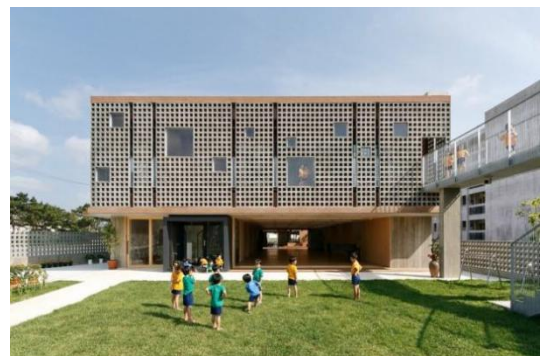
Hình 14. Mặt đứng trường học ở Nhật (Công ty Vật liệu xây dựng Milli, 2019)
